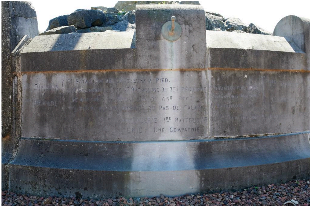
Vue de détail du panneau latéral 4 (numérotation depuis le panneau central avant dans le sens des aiguilles d'une montre).
