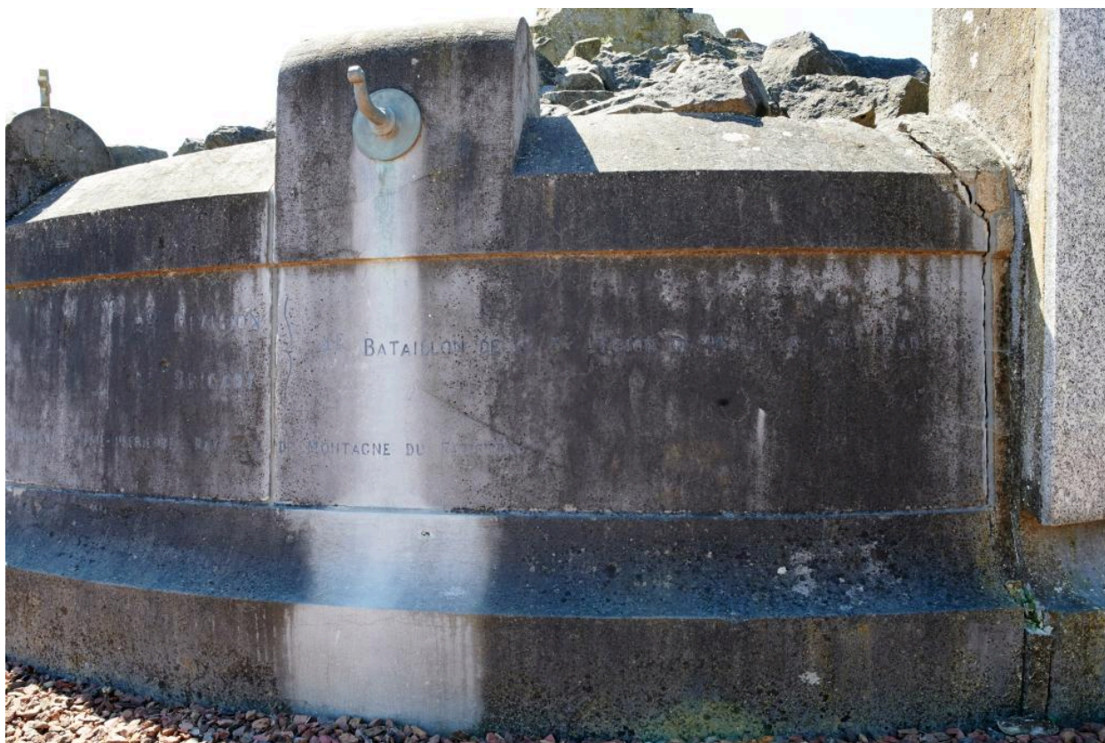
Vue de détail du panneau latéral 5 (numérotation depuis le panneau central avant dans le sens des aiguilles d'une montre).
