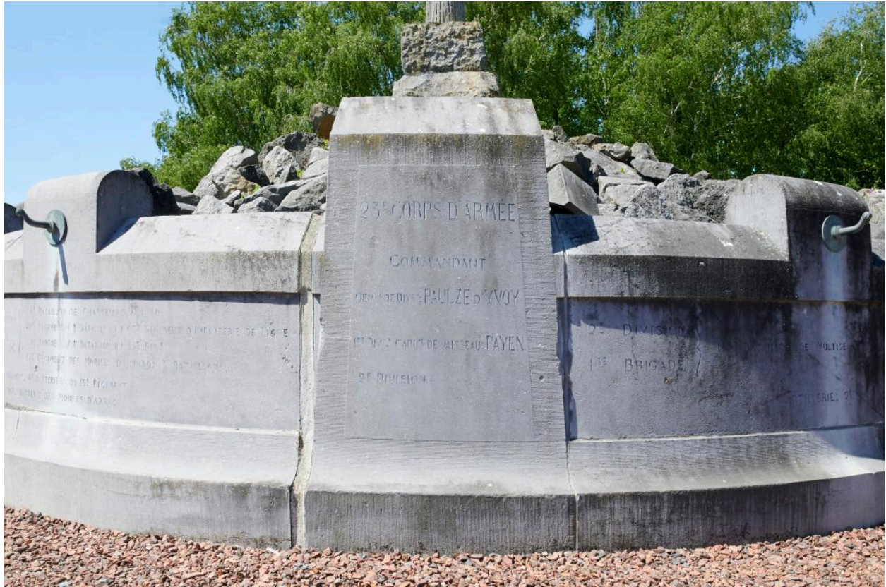
Vue de détail du panneau latéral 7 (numérotation depuis le panneau central avant dans le sens des aiguilles d'une montre).
