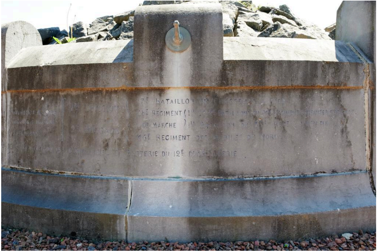
Vue de détail du panneau latéral 3 (numérotation depuis le panneau central avant dans le sens des aiguilles d'une montre).
