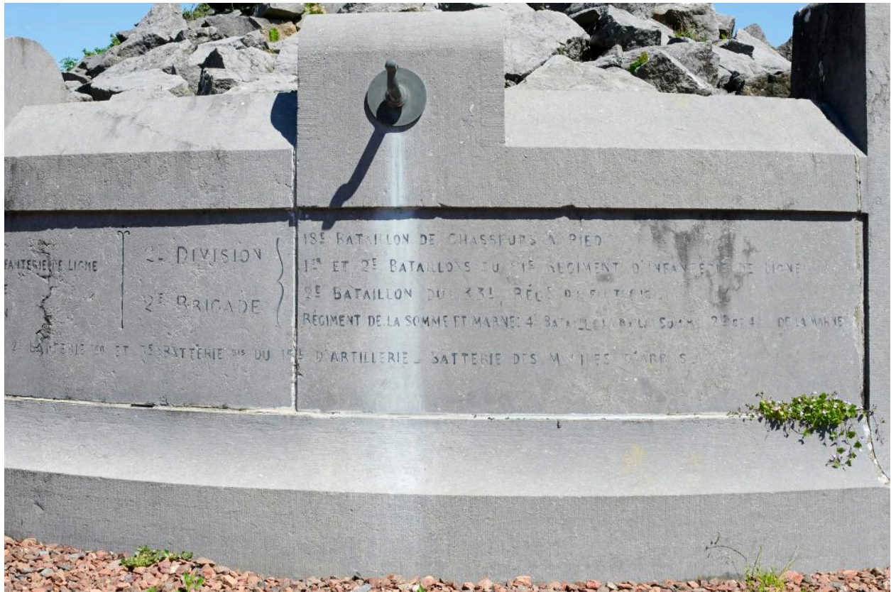
Vue de détail du panneau latéral 1 (numérotation depuis le panneau central avant dans le sens des aiguilles d'une montre)..
