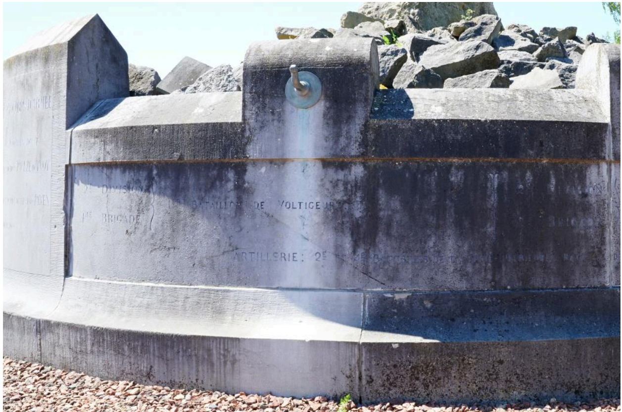
Vue de détail du panneau latéral 6 (numérotation depuis le panneau central avant dans le sens des aiguilles d'une montre).
