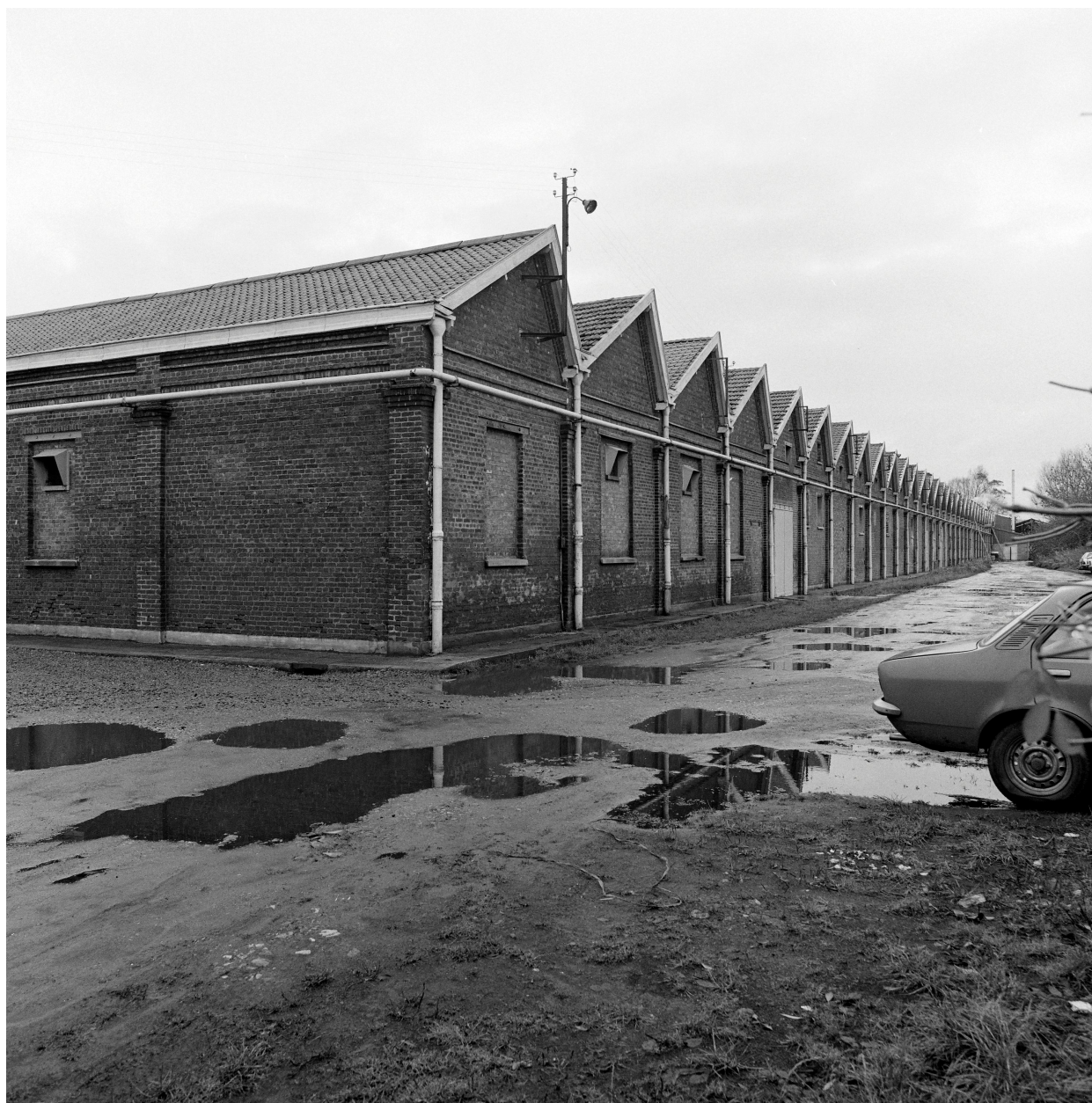
Atelier de fabrication, élévation sur cour.
