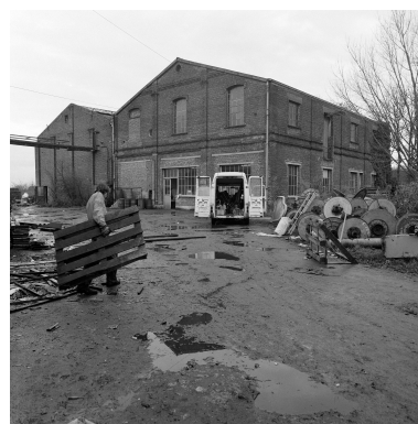
Ancienne chaufferie. Phot. Olivier Marlard IVR31_19885902282X
