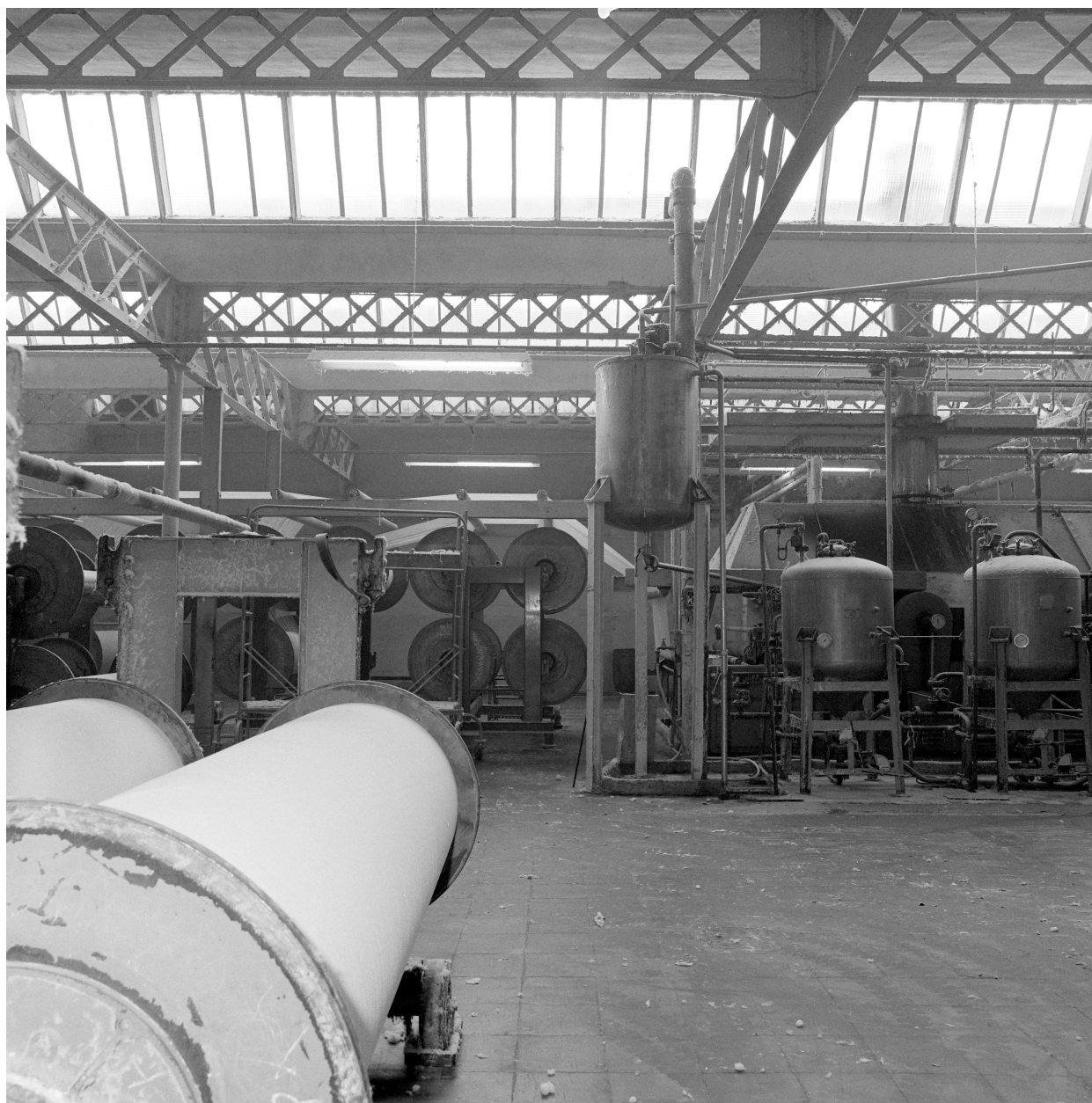
Atelier de fabrication (ensouplage), vue intérieure.
