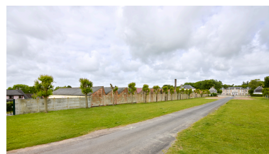
Vue d'ensemble de l'usine, depuis la place de la Mairie. Phot. Thierry Lefébure IVR32_20258001575NUCA
