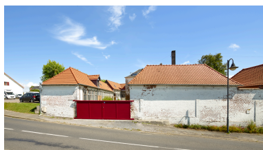
Vue des premiers ateliers, depuis l'ouest. Phot. Thierry Lefébure IVR32_20258001577NUCA
