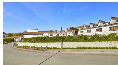
Vue d'ensemble de l'usine, depuis l'est. Phot. Thierry Lefébure IVR32_20258001568NUCA
