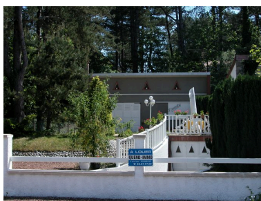
Maison dite l'Oustalou (avenue des Chênes, AD 53) construite vers 1961 pour Adrien Calvet-Ménard, ébéniste à Levallois-Perret. Phot. Elisabeth Justome IVR22_20058004009NUCA
