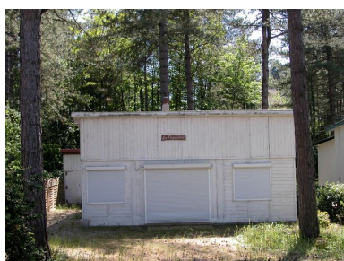
Maison dite Les Papounnets (2 avenue des Sapinettes, AD 48) construite vers 1960 pour Gaston Prévost demeurant à Arras (62). Phot. Elisabeth Justome IVR22_20058004007NUCA
