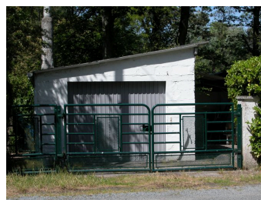
Détail d'un garage isolé et d'une clôture (angle avenues des Chênes et des Peupliers, AD 86). Phot. Elisabeth Justome IVR22_20058004008NUCA
