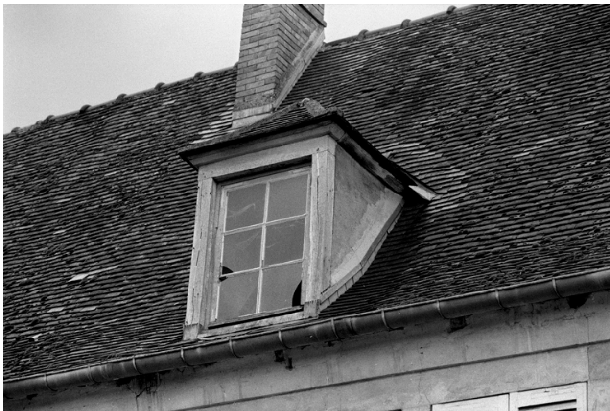
Détail de lucarnes.
