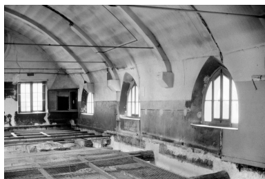
Vue de la chapelle : charpente.
