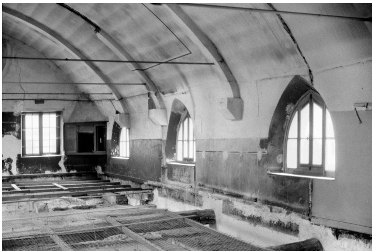
Vue de la chapelle : charpente.
