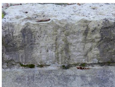
Détail sur la signature de l'architecte. Phot. Isabelle Barbedor IVR32_20168006473NUCA
