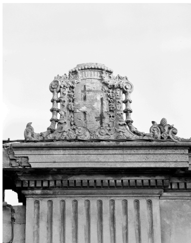
Élévation antérieure. Blason n° 7 (illisible). Phot. Philippe Dapvril IVR31_19885900043X
