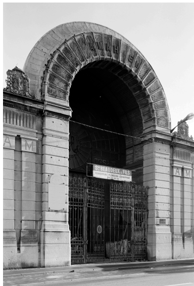
Élévation antérieure, travée centrale. Phot. Philippe Dapvril IVR31_19885900036X
