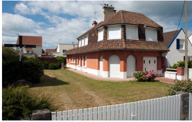
Vue générale. Phot. Pierre Thibaut IVR31_20146202174NUCA
