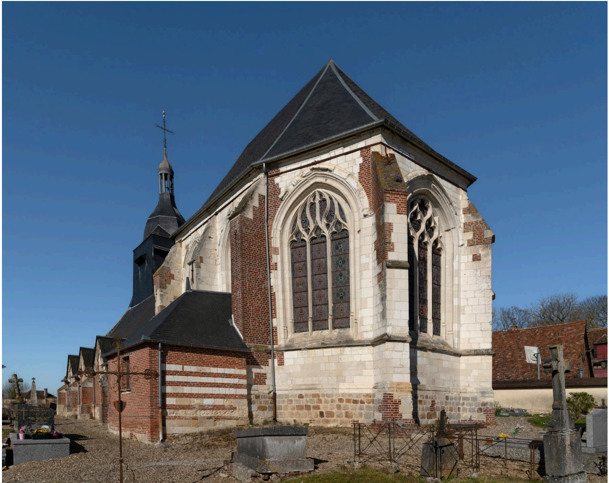
Chevet et sacristie, vue du sud-est.
