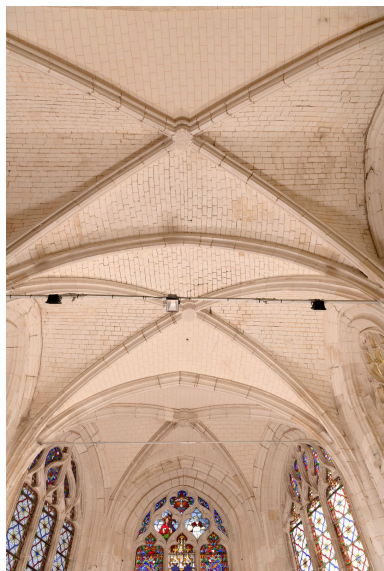
Voûtes du chœur. Phot. Marc Kérignard IVR32_20256000288NUCA
