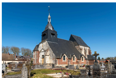
Vue générale depuis le sud-ouest. Phot. Marc Kérignard IVR32_20256000137NUCA
