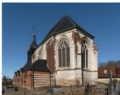
Chevet et sacristie, vue du sud-est. Phot. Marc Kérignard IVR32_20256000107NUCA
