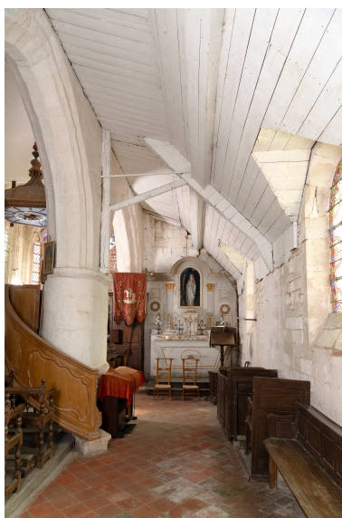
Vue générale du bas-côté sud. Phot. Marc Kérignard IVR32_20266000045NUCA
