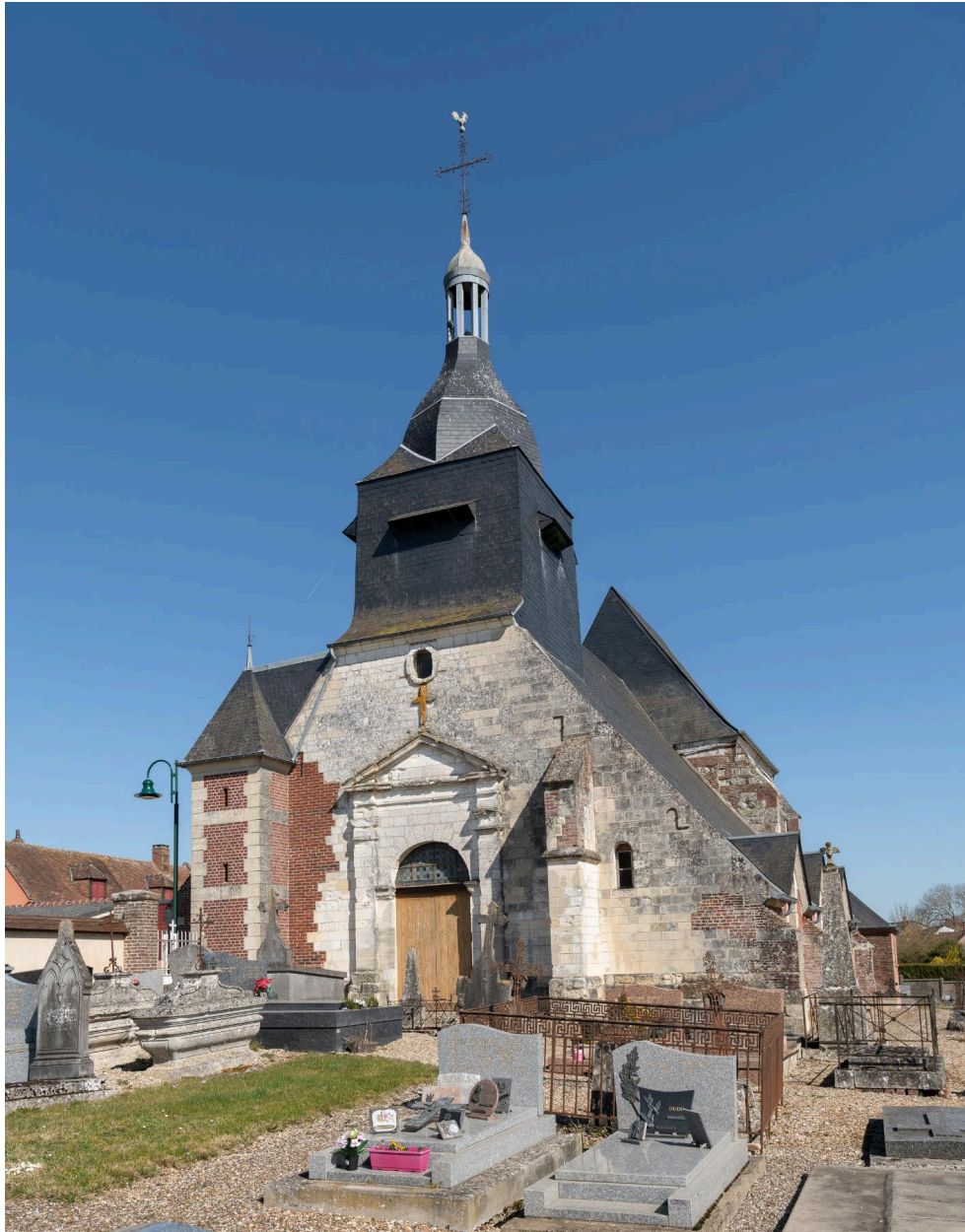
Vue générale de la façade occidentale.
