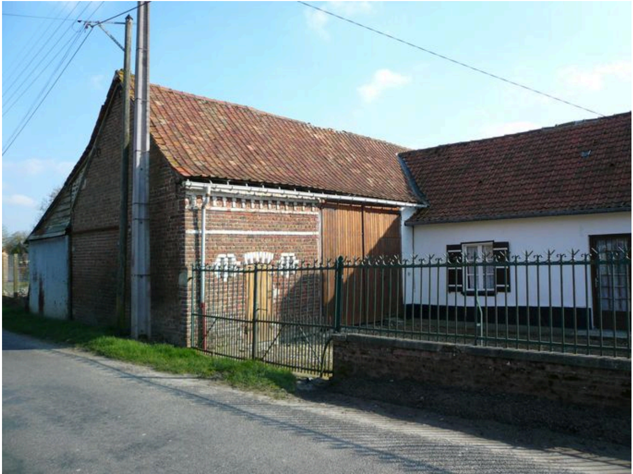
Vue de la grange et de l'étable accolées au logis.
