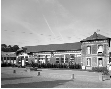
Vue d'ensemble de la façade. Phot. Thierry Lefébure IVR22_19910201433V
