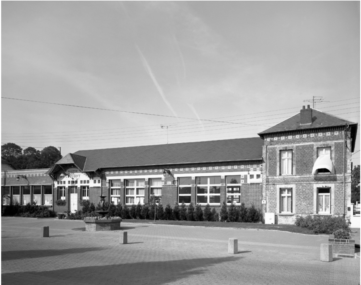
Vue d'ensemble de la façade.
