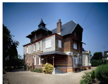
Elévation antérieure. Phot. Fabrice Charrondière IVR22_19866000109VA
