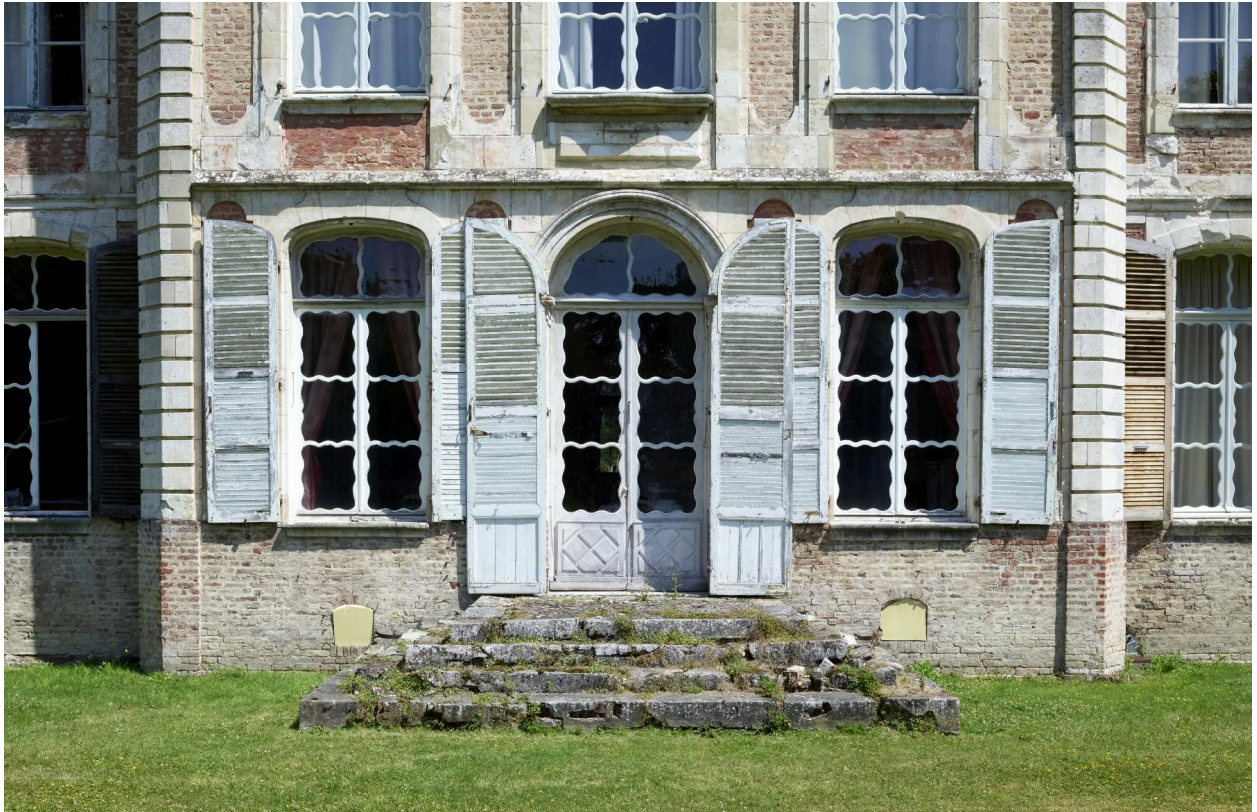
Détail des travées centrales du rez-de-chaussée de l'avant-corps du château.
