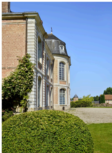
Façade nord avec le détail de l'avant- corps central vue depuis l'est. Phot. Thierry Lefébure IVR32_20258001161NUCA
