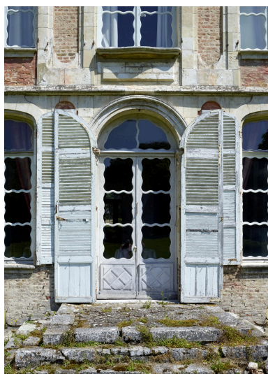
Détail de la porte d'entrée centrale donnant accès au grand salon. Phot. Thierry Lefébure IVR32_20258001169NUCA
