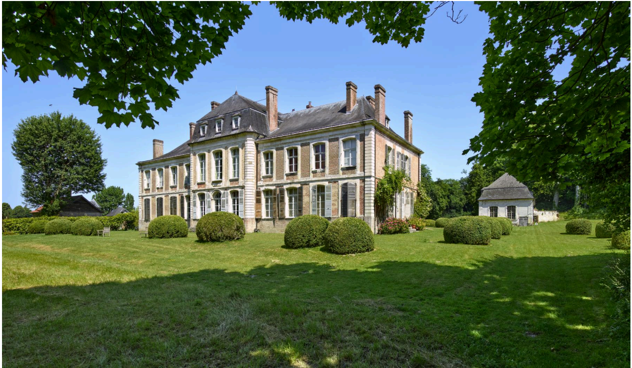
Vue de trois quarts depuis le sud-est.
