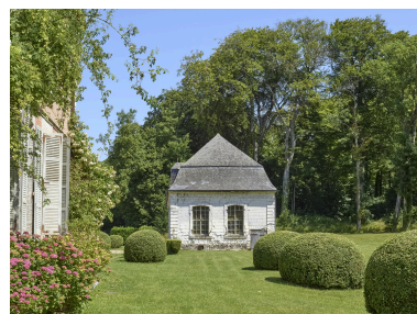
Pignon sud du pavillon situé au nord-est du château. Phot. Thierry Lefébure IVR32_20258001170NUCA
