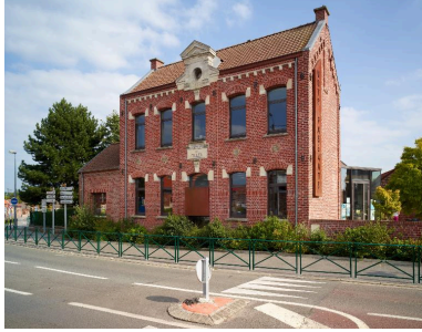
Vue générale de trois quarts. Phot. Pierre Thibaut IVR31_20155901595NUCA
