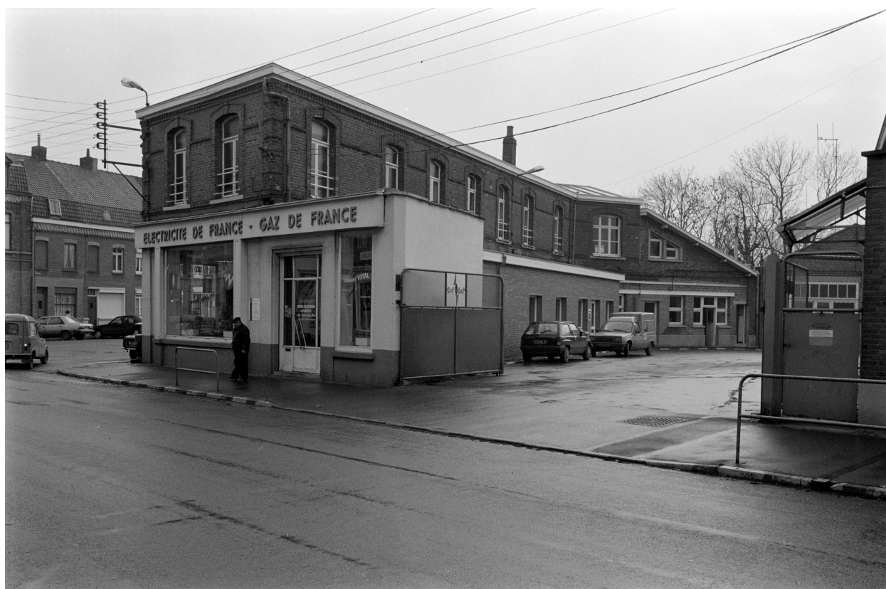
Bureaux. Vue prise vers l'est.
