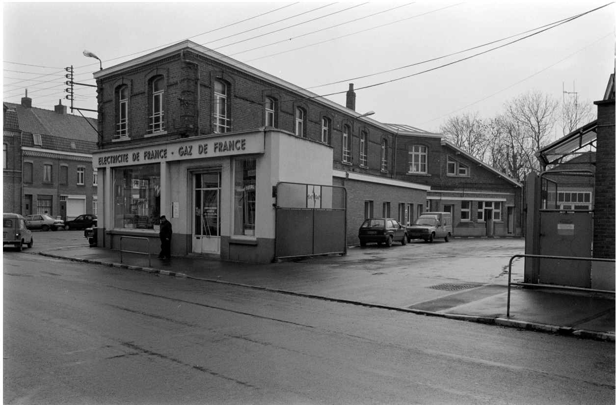
Bureaux. Vue prise vers l'est.
