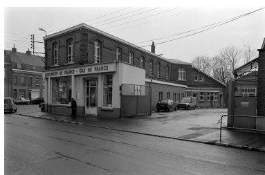
Bureaux. Vue prise vers l'est.
