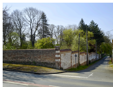
Mur de clôture du parc ente la route de Paris et l'impasse du Hamel, depuis le nord. Phot. Thierry Lefébure IVR32_20258000619NUCA
