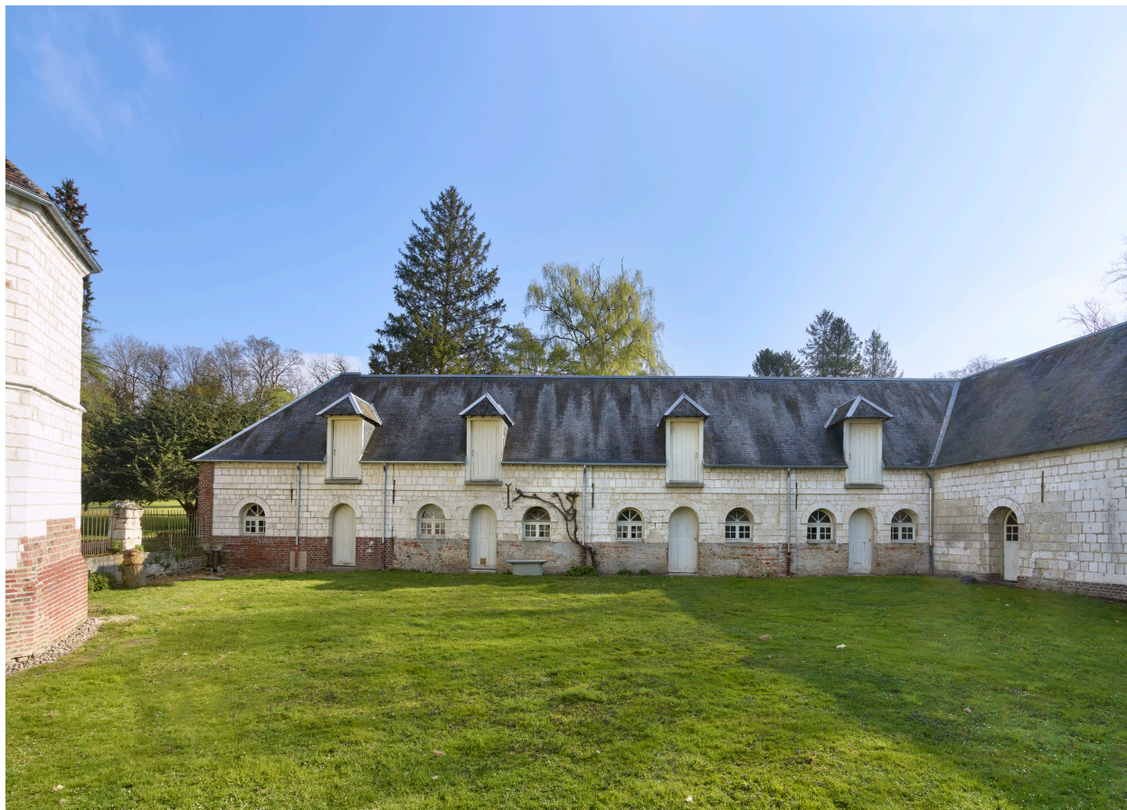
Vue du bâtiment nord de la ferme, depuis la cour.
