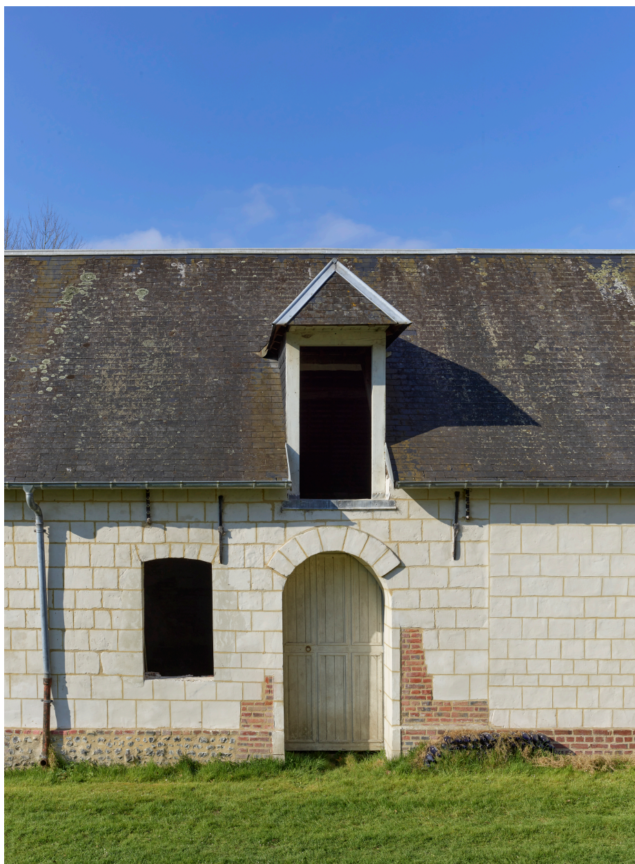
Travée du bâtiment sud de la ferme, depuis la cour.
