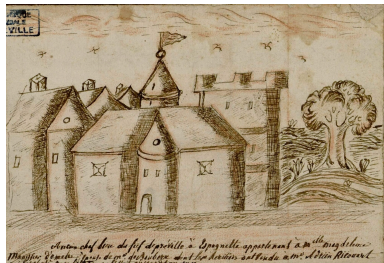
Ancien chef-lieu du fief de Préville, ancien château d'Épagnette ? Collection Delignières de Bommy de Saint-Amand, [s.d.] (Archives et Bibliothèque patrimoniale d'Abbeville ; Vol 2,Page 50). Repro. Abbeville, archives et bibliothèque patrimoniale IVR32_20258011034NUCA
