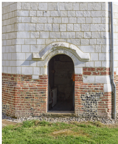
Détail de la porte du pigeonnier. Phot. Thierry Lefébure IVR32_20258000645NUCA
