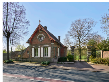
Maison du gardien, depuis la rue. Phot. Thierry Lefébure IVR32_20258000616NUCA
