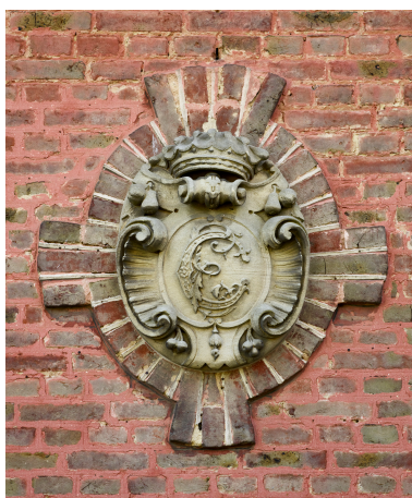
Blason sur la maison de gardien. Phot. Thierry Lefébure IVR32_20258000618NUCA
