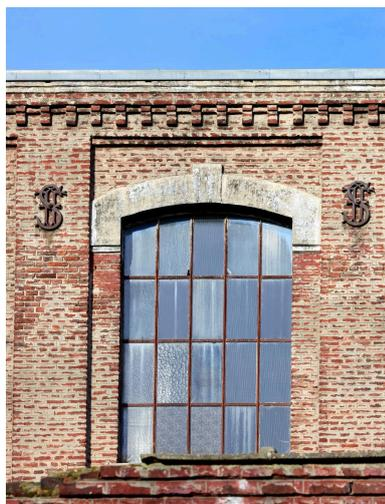
Détail d'une ouverture du deuxième étage de l'ancien atelier de fabrication encadré de fers d'ancrage portant les initiales de l'industriel.
