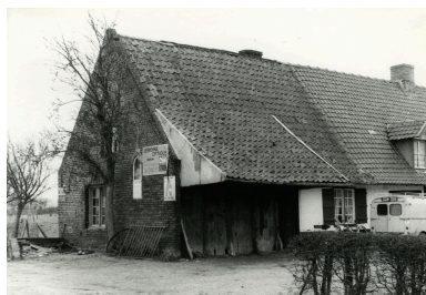
Ancien atelier, vue sur cour. 1979 (coll. Comité Flamand de France). Repro. Delphine Volto Jourdan IVR32_20255900341NUCAB
