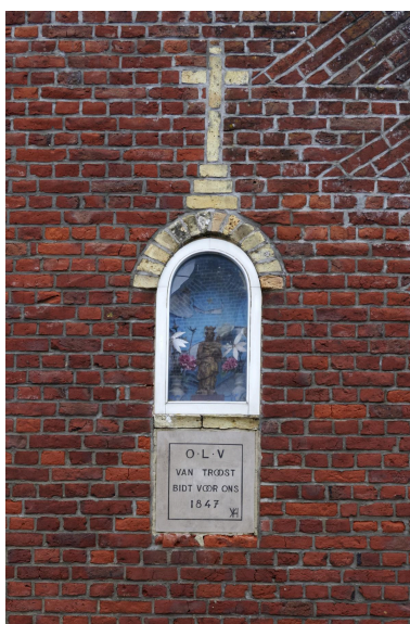
Détail de la niche votive du pignon ouest. Phot. Delphine Volto Jourdan IVR32_20245902958NUCA
