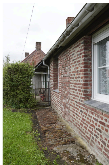
Détail du trottoir en brique situé le long du mur nord. Phot. Delphine Volto Jourdan IVR32_20245902959NUCA
