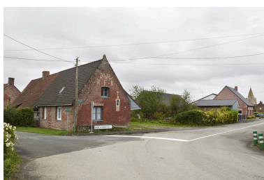
Façade nord et pignon ouest, depuis le carrefour. Phot. Delphine Volto Jourdan IVR32_20245902966NUCA
