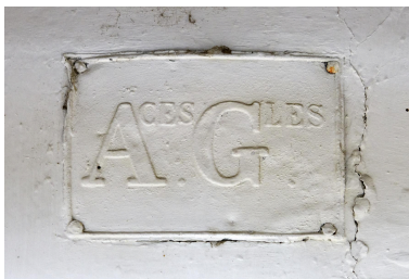
Plaque métallique sur le mur sud. Phot. Delphine Volto Jourdan IVR32_20245902962NUCA
