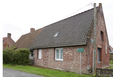
Détail de la façade nord, sur rue. Phot. Delphine Volto Jourdan IVR32_20245902960NUCA
