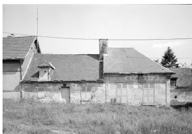
Logis. Elévation antérieure. Phot. Jean-Michel Perrin IVR22_19856000895X
