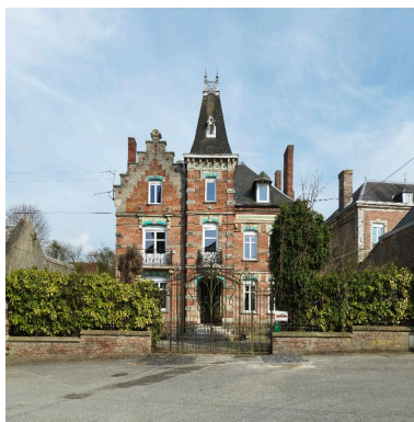
Vue d'ensemble. Phot. Thierry Lefébure IVR22_20138000087NUC2A
