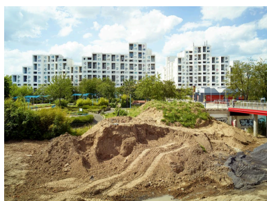
Quartier Le Pont-de-Bois : chantier à l'emplacement de l'ancien collège Léon-Blum, 2019. Au fond : l'îlot 4. Phot. Pierre Thibaut IVR32_20195900780NUCA
