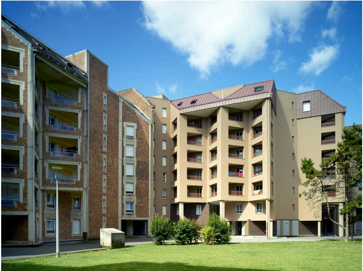
L'îlot 41 (quartier l'Hôtel-de-Ville) en cours d'isolation par l'extérieur (à droite).
