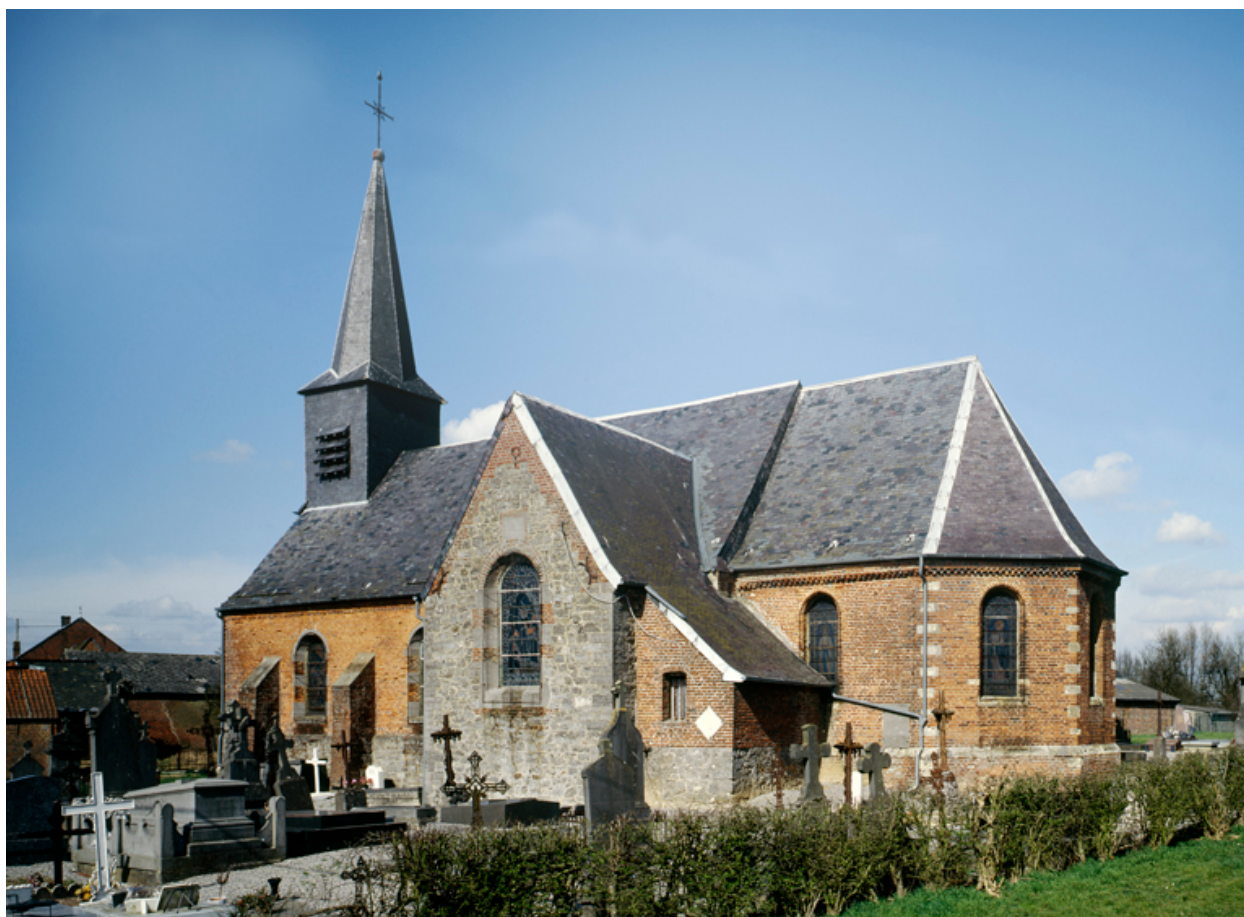
Vue générale, depuis le sud-est.
