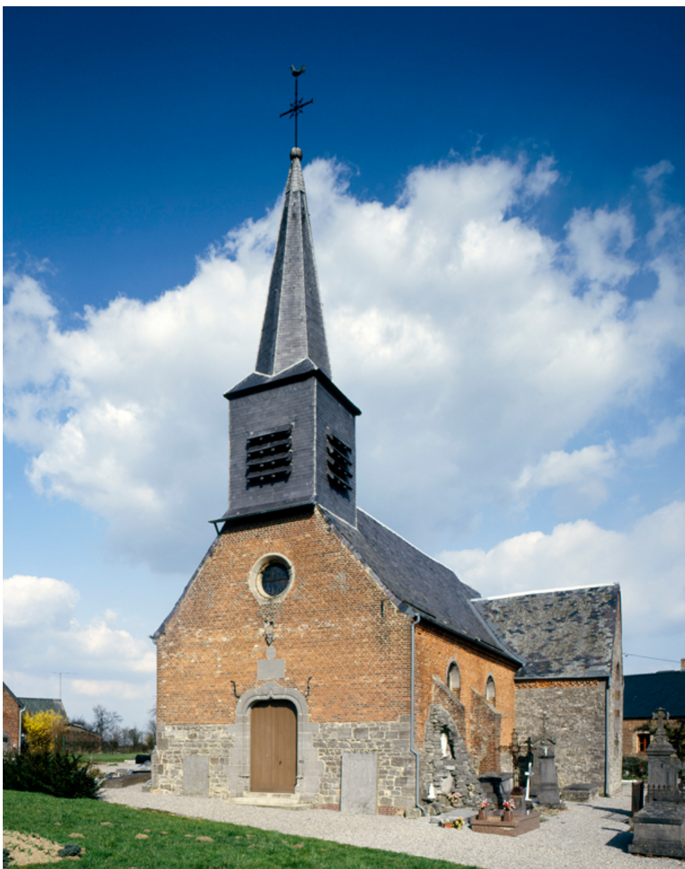
Vue générale depuis le sud-ouest.
