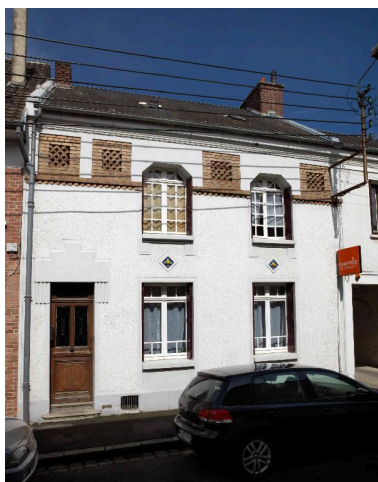
Maison, 9 rue de Sorigny. Phot. Marie-Laure Monnehay-Vulliet IVR32_20168000128NUC2A
