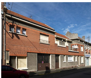
Maison d'artisan, 25 rue Notre-Dame. Phot. Marie-Laure Monnehay-Vulliet IVR32_20168000115NUC2A
