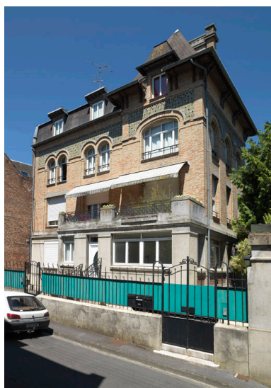
Demeure et agence de l'architecte Henry Brassart, rue Vadé. Phot. Marie-Laure Monnehay-Vulliet IVR22_20158000618NUC2A
