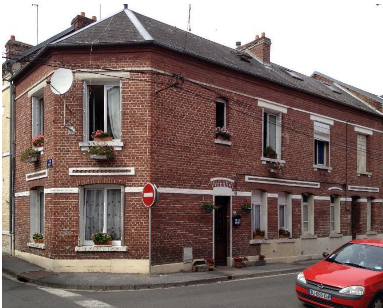
Maison d'angle, 7 et 9 rue du Grenier-à-sel.
