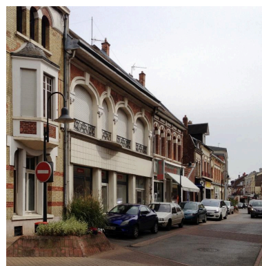
Maisons à boutique, 1 et 3 rue du Général-Foy. Demeure et ancien atelier de l'ébéniste J. Vidal. Phot. Isabelle Barbedor IVR22_20158006118NUCA
