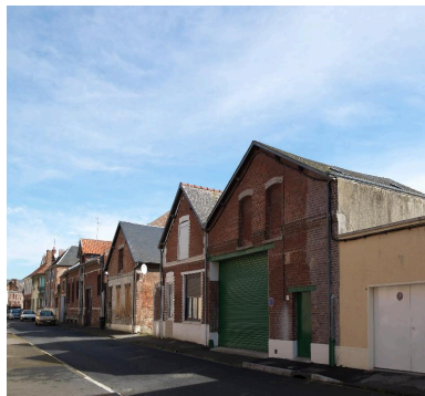
Entrepôts, rue Marchande. Phot. Marie-Laure Monnehay-Vulliet IVR32_20168000121NUC2A
