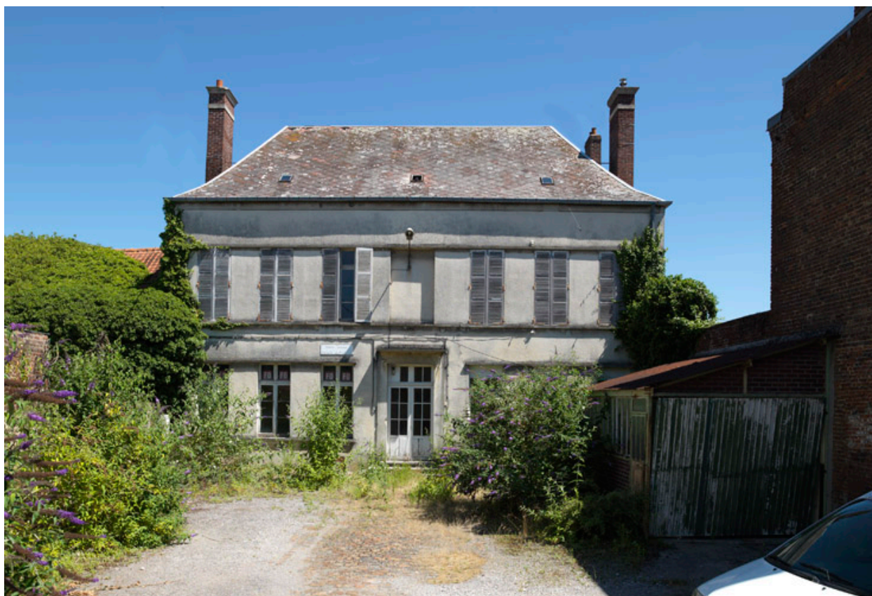
Ancienne école de filles, 33 rue Général-Leclerc (ancienne rue de Chauny).
