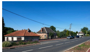
Maison, boulevard du Midi. Phot. Marie-Laure Monnehay-Vulliet IVR22_20158000887NUC2A
