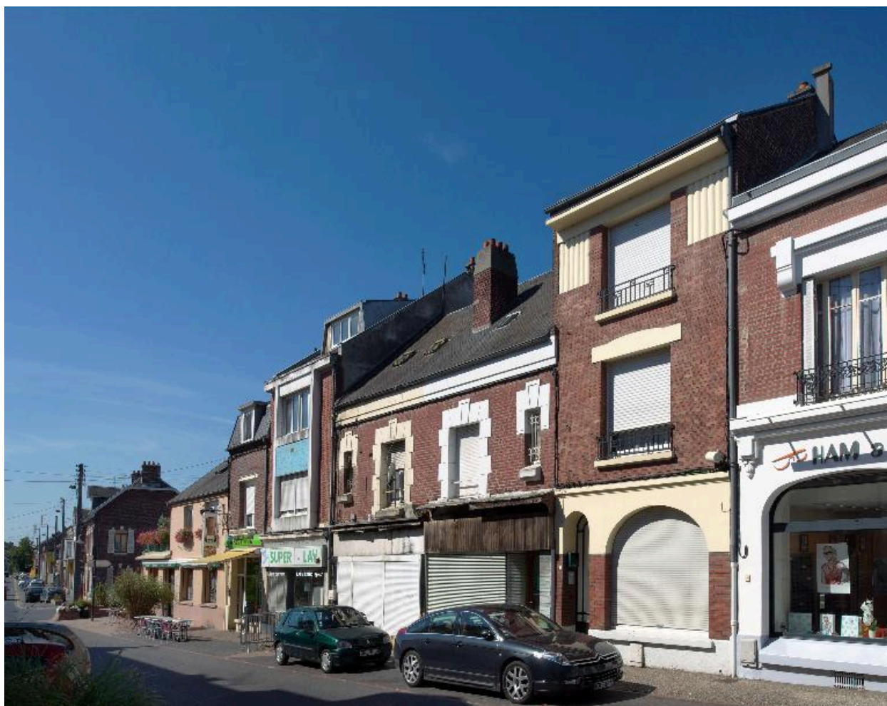
Rue de Noyon, rive ouest. L'ancien hôtel.
