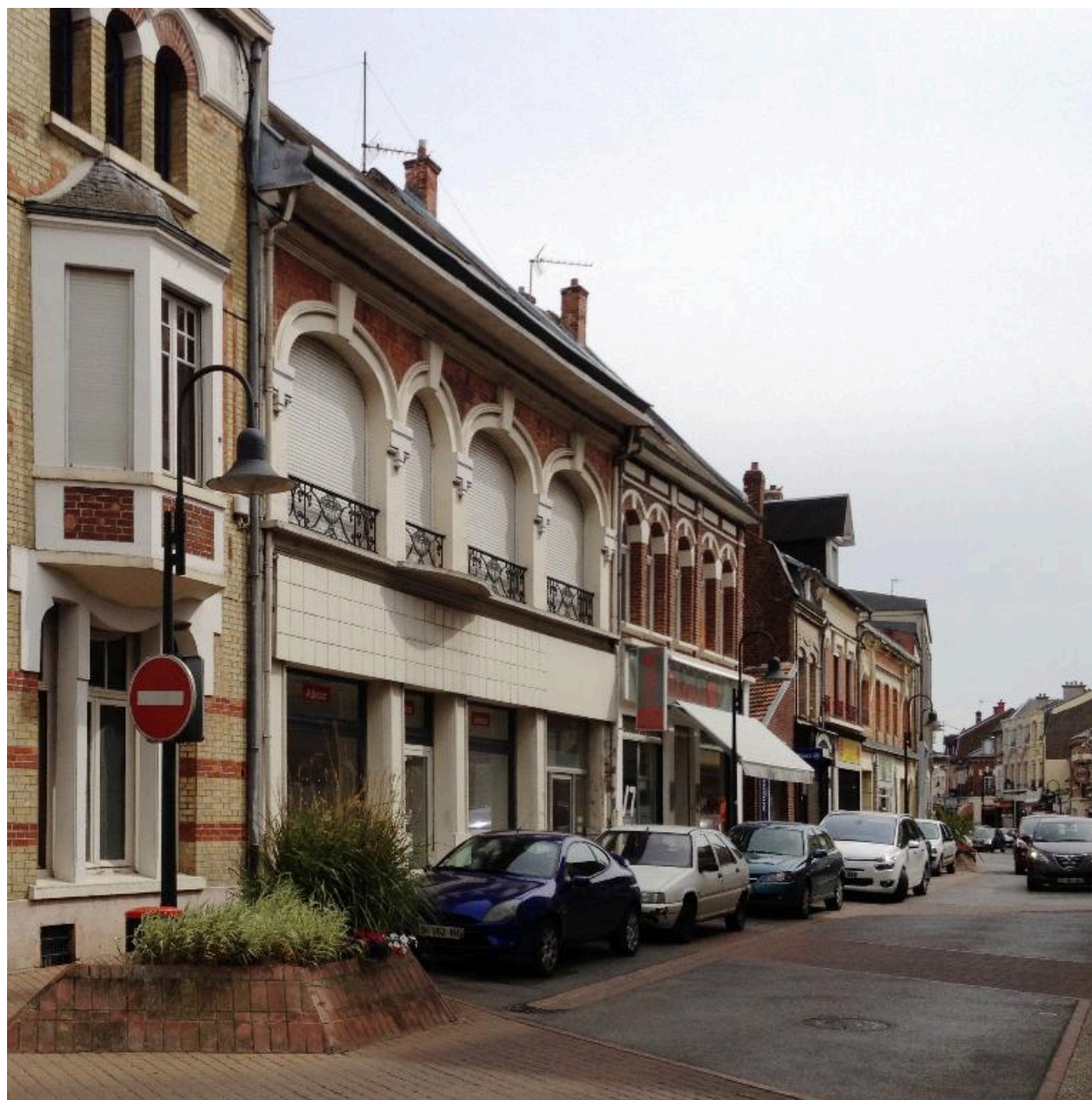
Maisons à boutique, 1 et 3 rue du Général-Foy. Demeure et ancien atelier de l'ébéniste J. Vidal.
