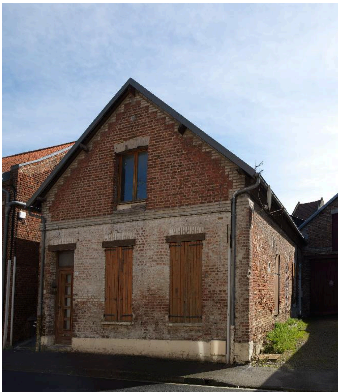
Maison, 23 rue Marchande.
