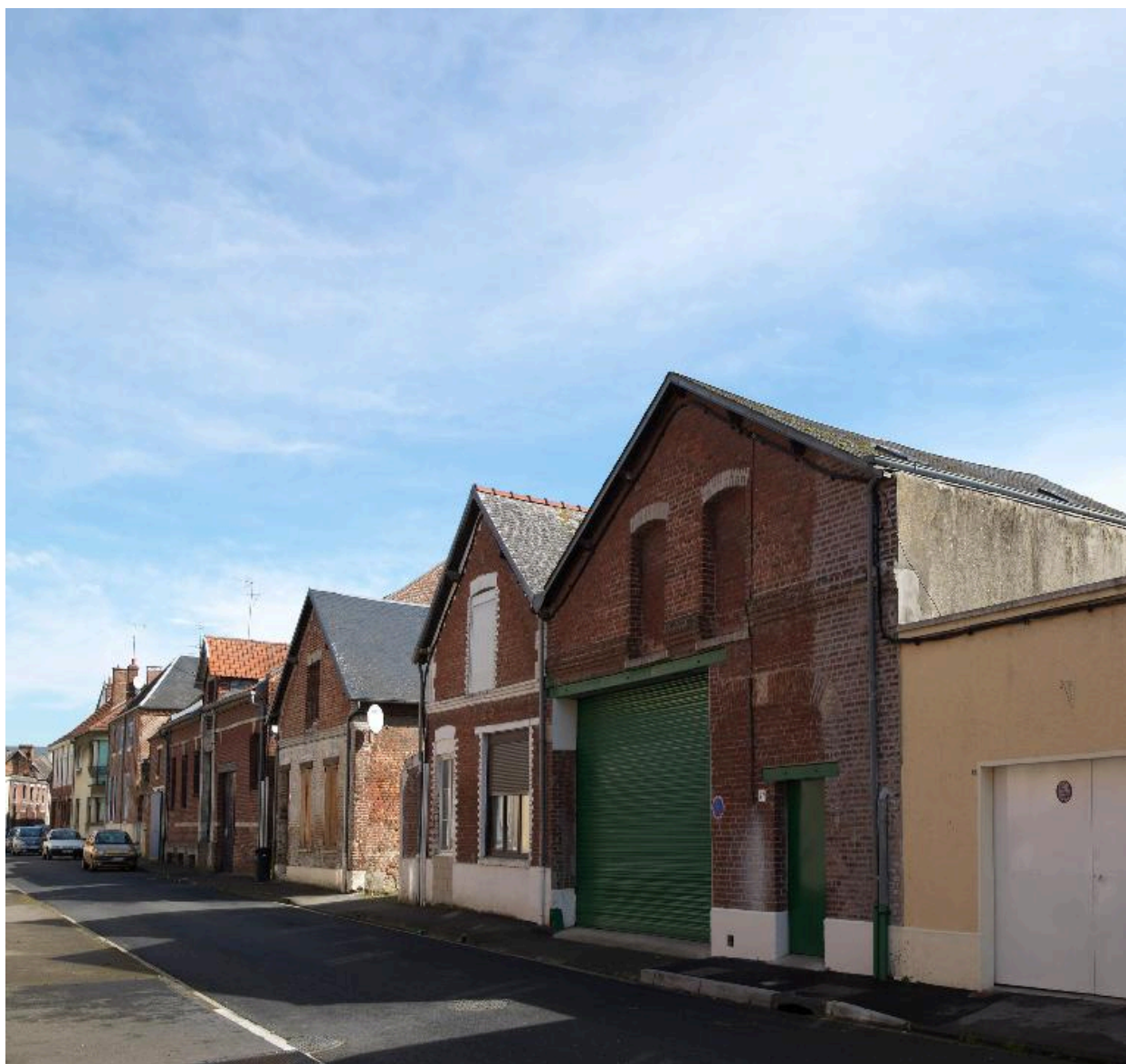
Entrepôts, rue Marchande.
