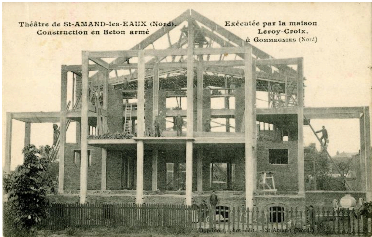
Le théâtre en construction, carte postale sans date (Médiathèque de Saint-Amand-les-Eaux).
