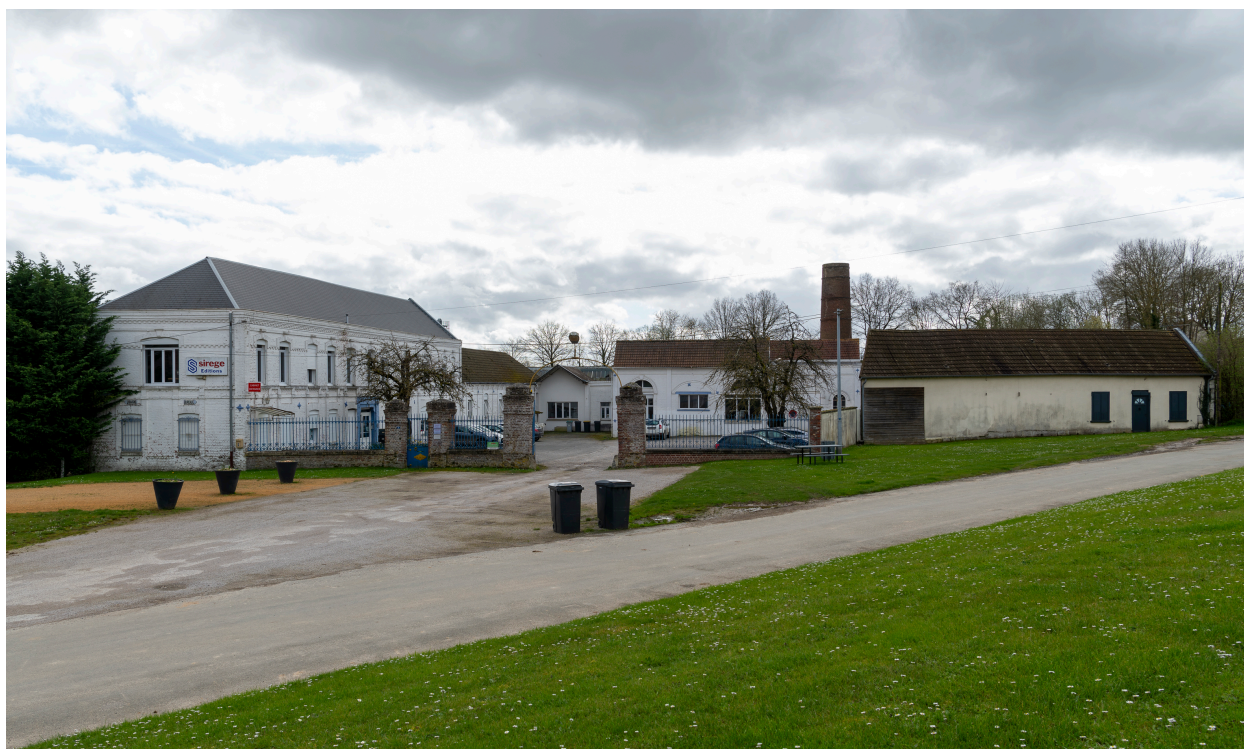
Vue générale de l'usine depuis le nord.
