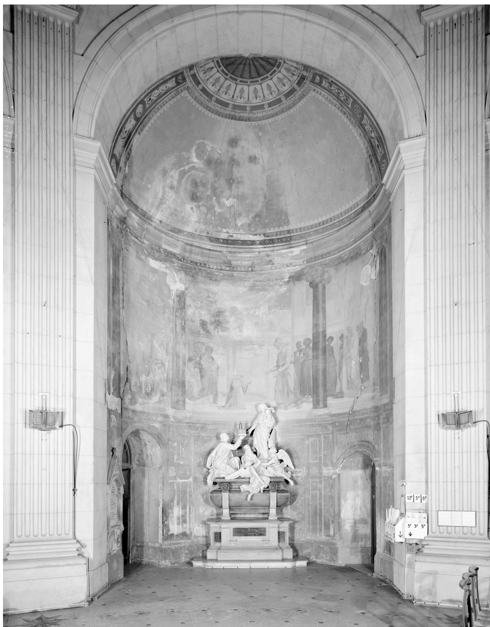
Vue générale avant restauration.
