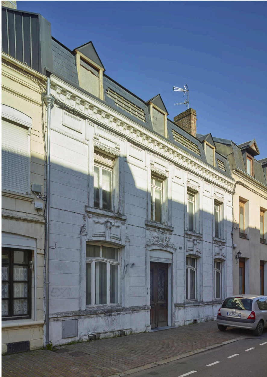
Façade principale sur la rue Victor-Hugo. Vue orientée est/ouest.
