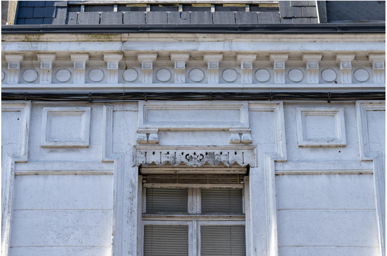
Détail du décor de tables affleurées et de la corniche sommitale soutenant le chéneau.
