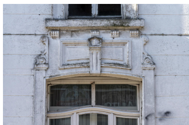
Détail du décor de tables affleurées dans les pleins de travée et des couronnements des pieds-droits des baies. Phot. Pierre Thibaut IVR32_20255900280NUCA
