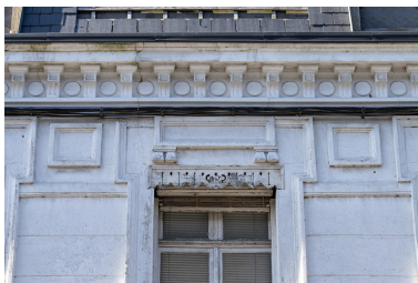
Détail du décor de tables affleurées et de la corniche sommitale soutenant le chéneau. Phot. Pierre Thibaut IVR32_20255900279NUCA
