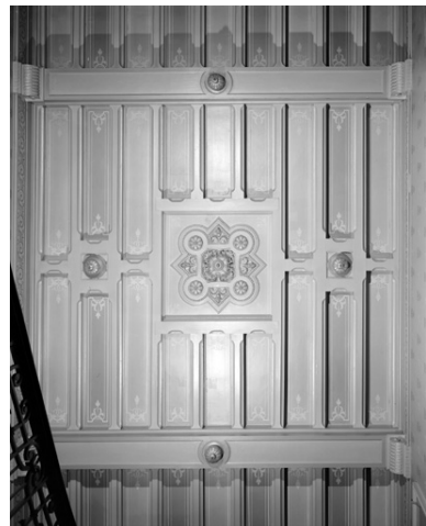
Plafond de la cage d'escalier, fin XIXe siècle. Phot. Thierry Lefébure IVR22_19900201380V
