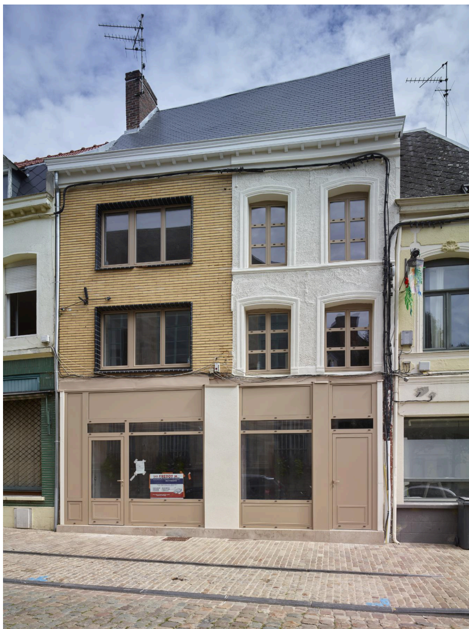
Maison - 40-42, rue du Maréchal-Joffre. Seule la partie gauche de la façade présente une façade en briques posées en appareil moderne et des entourages de baies en briques émaillées.
