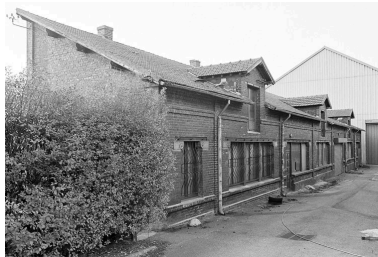
Remise, ateliers de fabrication secondaires. Phot. Benoît Dufournier IVR22_19936002434Z
