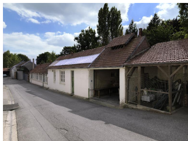
Vestiaires et anciens ateliers de fabrication. Phot. Thierry Lefébure IVR22_20158000822NUC2A
