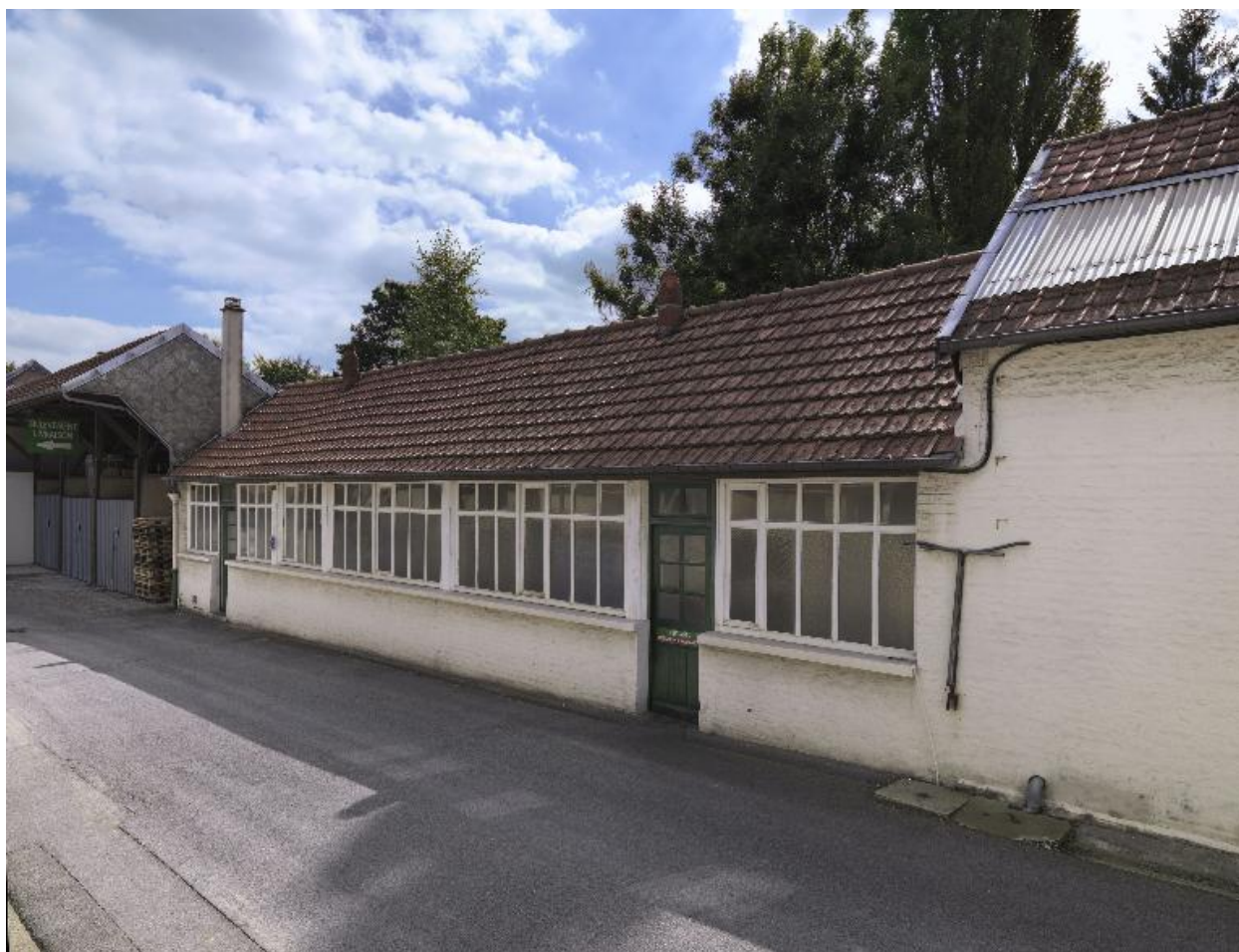
Anciens ateliers de fabrication, aujourd'hui vestiaires.
