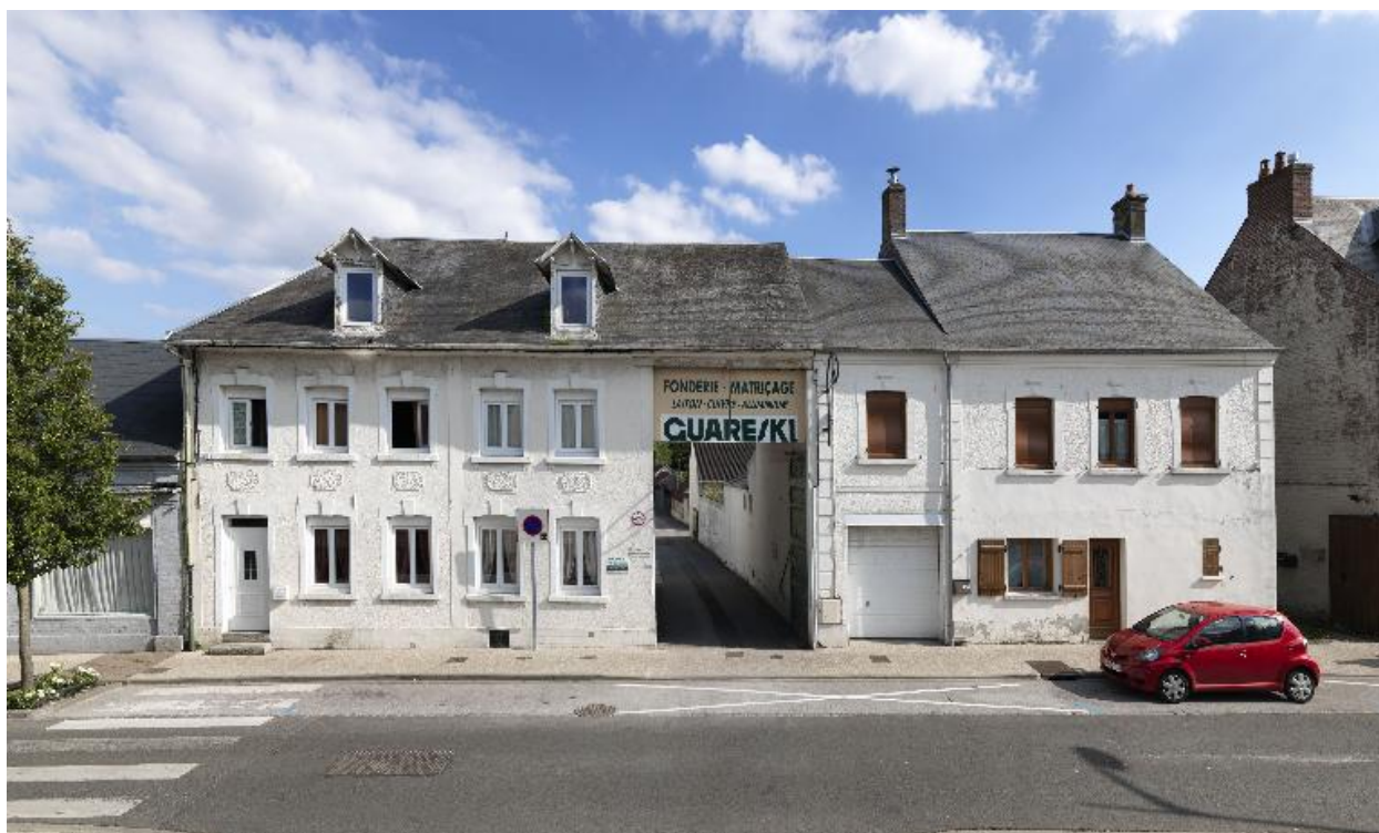
Vue générale sur rue.
