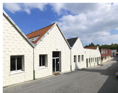
Bureaux et ateliers de fabrication. Phot. Thierry Lefébure IVR22_20158000821NUC2A
