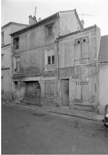
Elévation sur la rue. Phot. Thierry Lefébure IVR22_19940201176P
