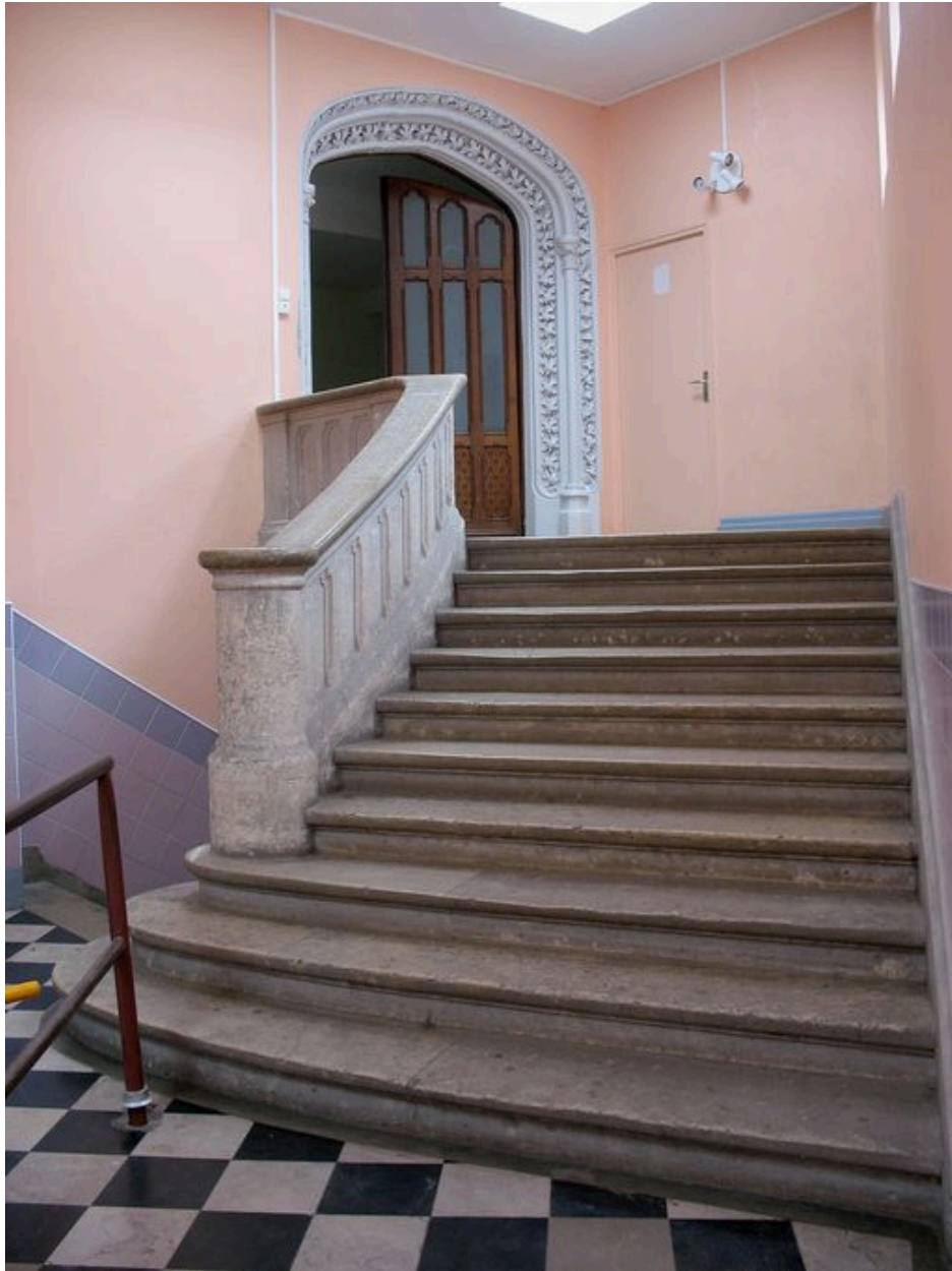
Accès vers la chapelle.
