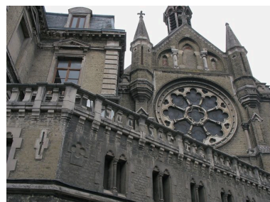
Détail de la façade de la chapelle. Phot. Bruno Decrock IVR31_20106208255NUCA
