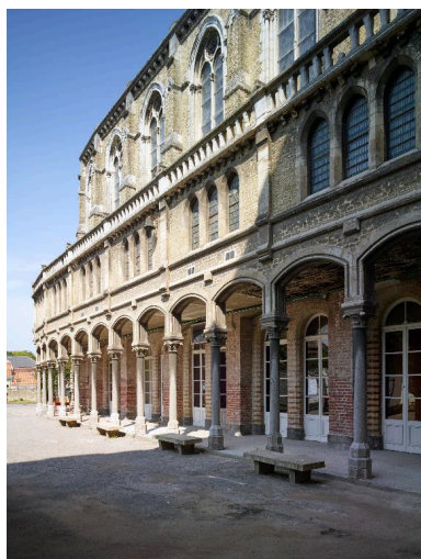
Vue de la chapelle basse et de la chapelle haute. Phot. Pierre Thibaut IVR32_20166200265NUCA
