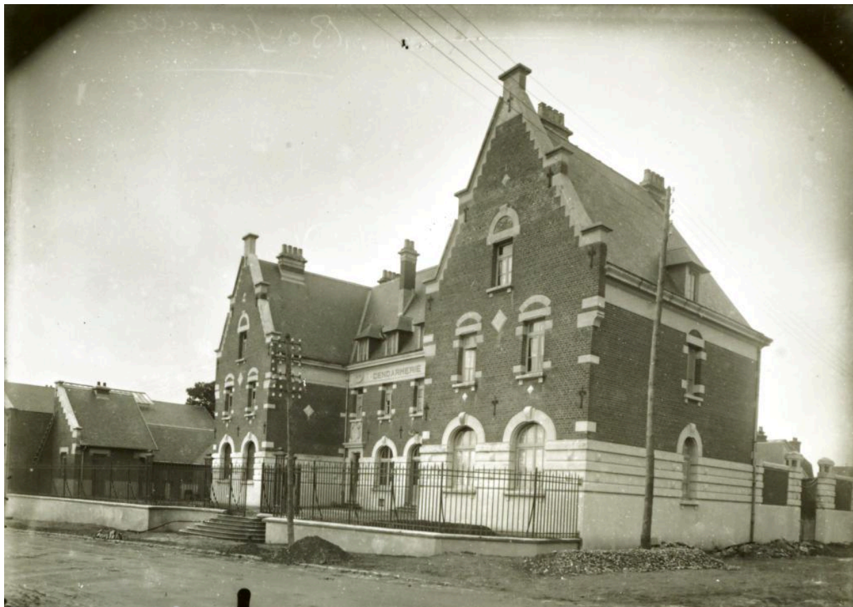
Photographie de fin du chantier réalisée par l'agence Decaux-Crével. (AD Pas-de-Calais, 45J548) Façade principale sur la rue de la République et du mur gouttereau sur la rue Gambetta.
