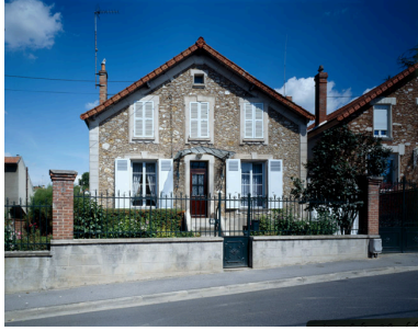
Vue d'ensemble depuis la rue. Phot. Thierry Lefébure IVR22_19930200952VA
