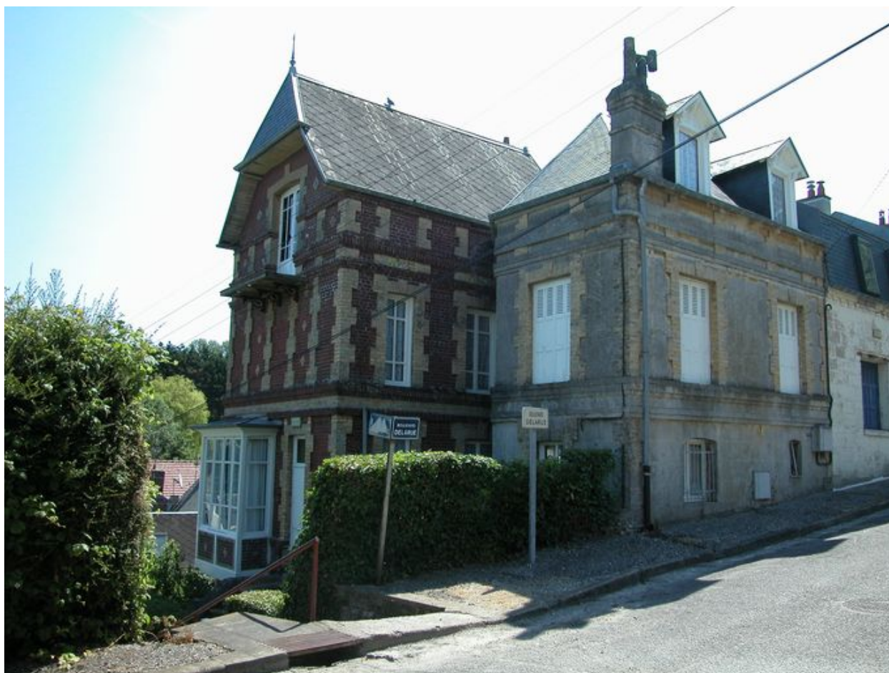
Vue d'ensemble depuis le boulevard Delarue.
