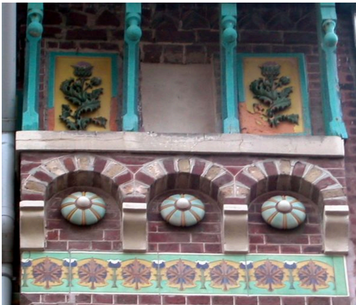
Détail du décor porté en façade.
