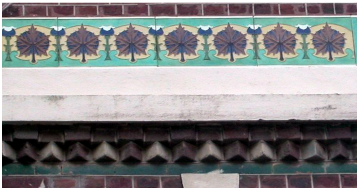
Détail du décor porté en façade.
