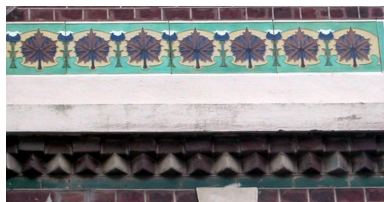
Détail du décor porté en façade.
