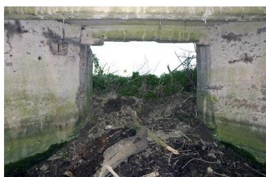
Intérieure de la chambre de tir, vers le front. On notera les échancrures à la base des murs permettant peut-être le blocage de l'affût du canon.
