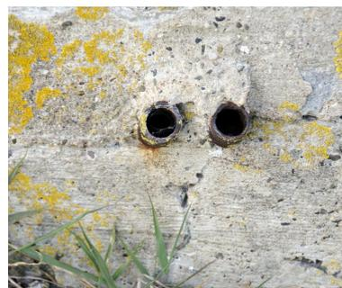
Tuyaux métalliques traversant le mur ouest de l'abri, sans doute pour permettre le passage de fils électriques ou téléphoniques.
