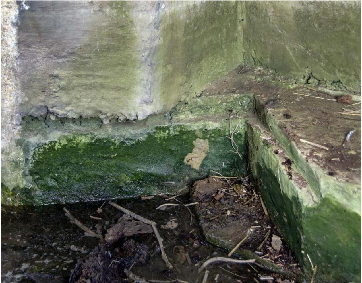
Détail de l'entaille à la base du mur qui permettait, peut-être, d'augmenter le débattement d'une pièce d'artillerie sur un chemin de roulement
