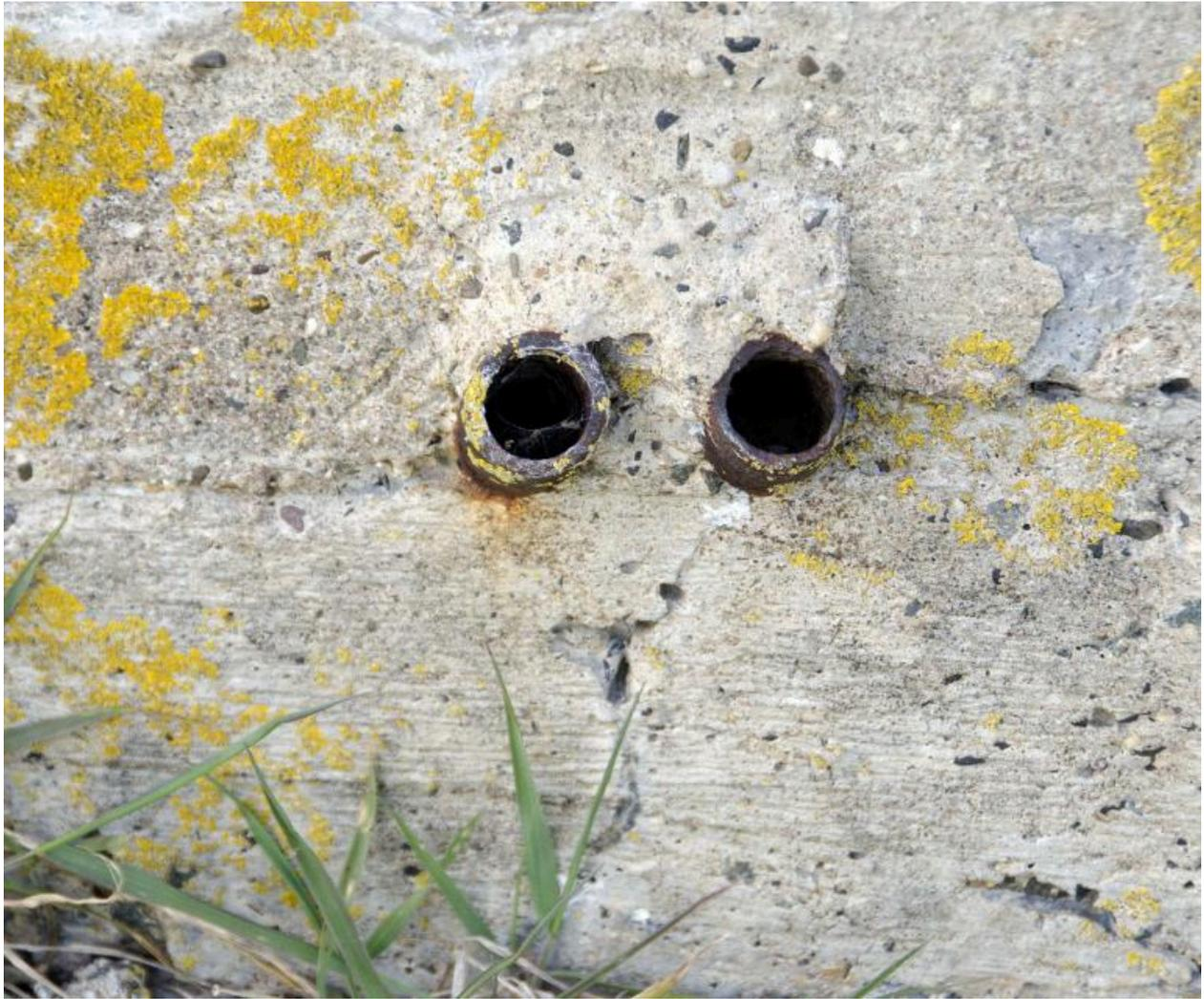
Tuyaux métalliques traversant le mur ouest de l'abri, sans doute pour permettre le passage de fils électriques ou téléphoniques.
