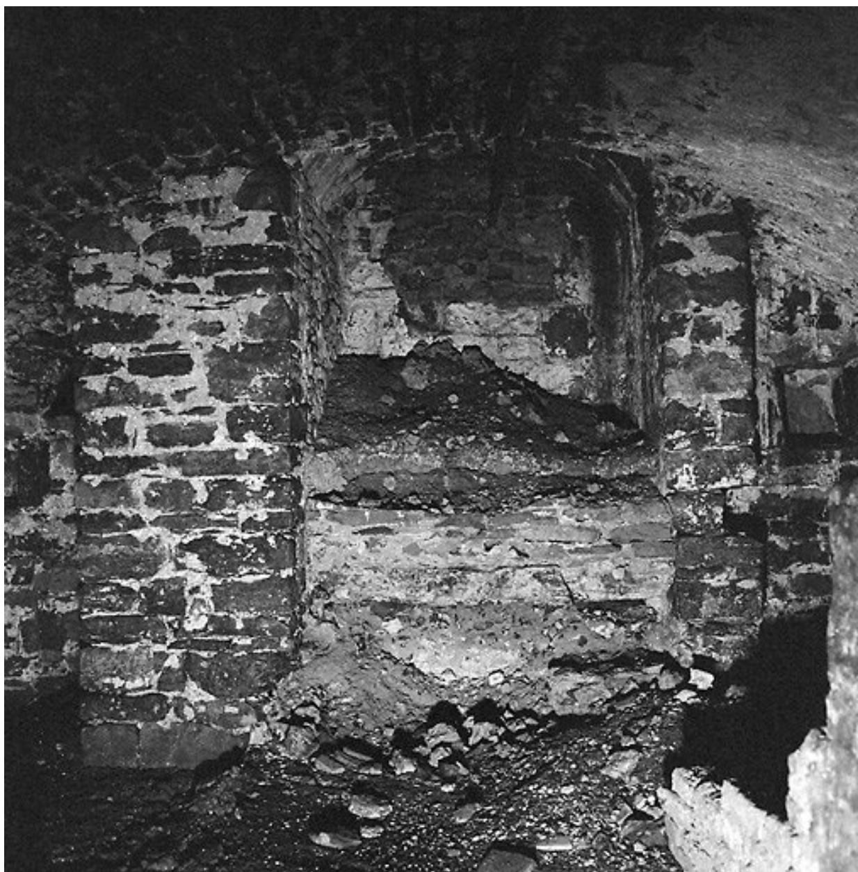
Sous-sol, cave sous la cour : mur vers la rue, ouverture de l'escalier d'origine donnant accès à la rue.
