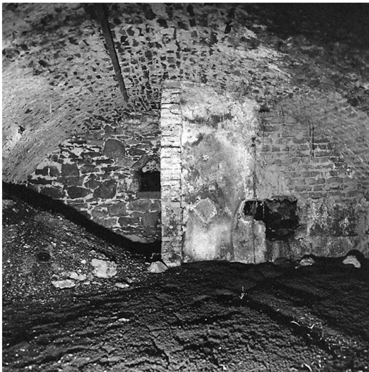
Sous-sol, cave sous la cour : vue axiale vers le mur arrière.
