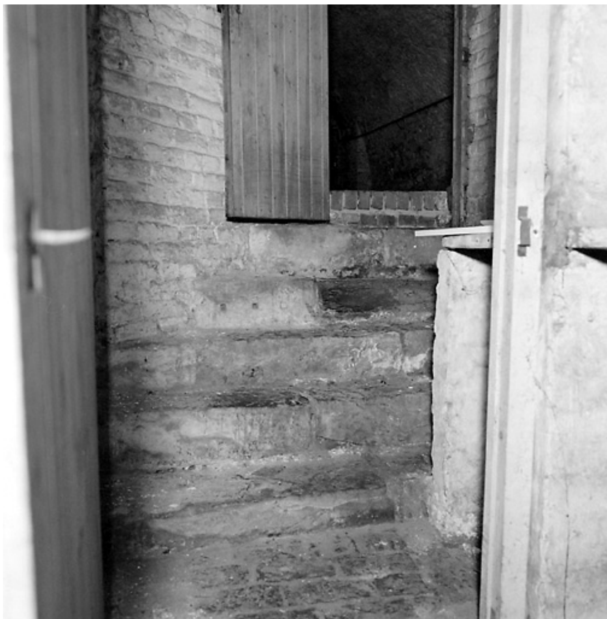
Sous-sol, cave arrière : escalier permettant l'accès à la cave principale.
