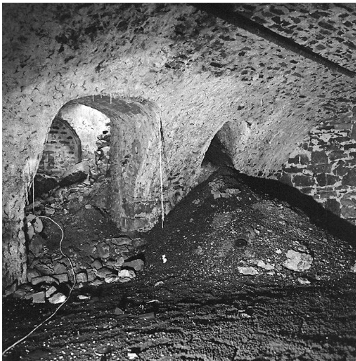
Sous-sol, cave sous la cour : vue diagonale vers l'arrière.
