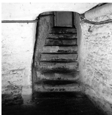
Sous-sol, cave principale : escalier d'accès actuel. Phot. Pierre Thibaut
