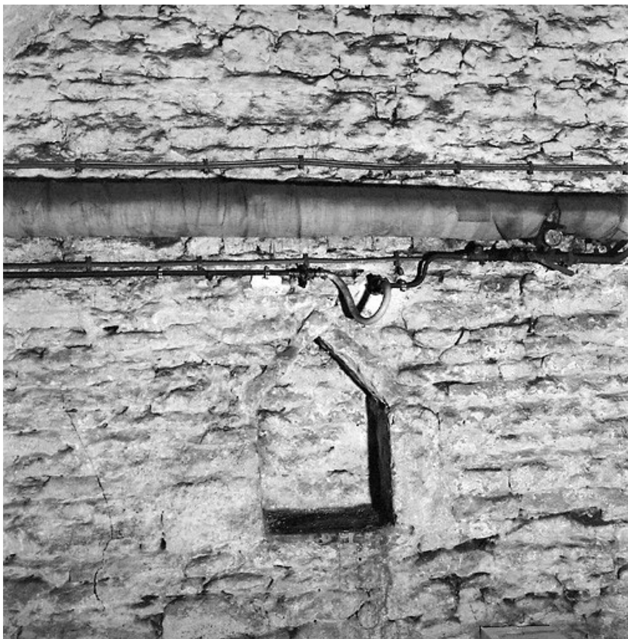
Sous-sol, cave principale : mur arrière, niche couverte en bâtière.
