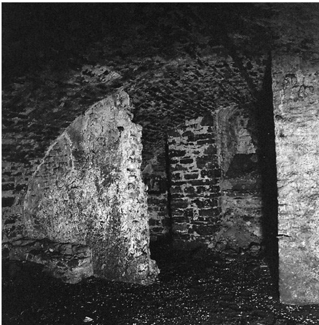
Sous-sol, cave sous la cour : vue diagonale vers l'angle nord-est.
