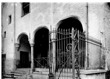
Édifice détruit pendant la Première Guerre mondiale, rez-de-chaussée, vue partielle : portique, vers 1900. Phot. Camille Enlart IVR31_20065906258NUC
