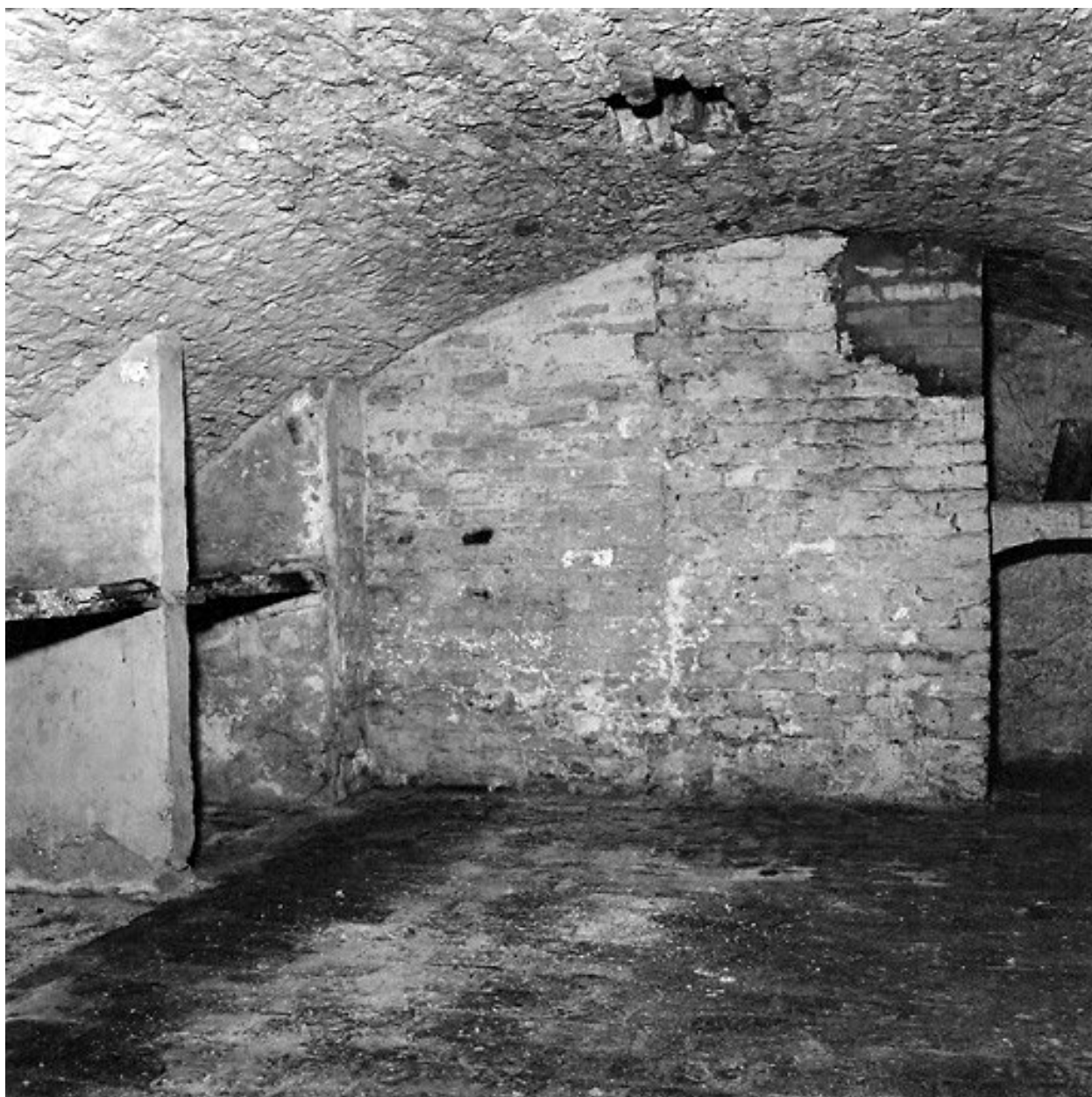
Sous-sol, cave arrière : mur sud.
