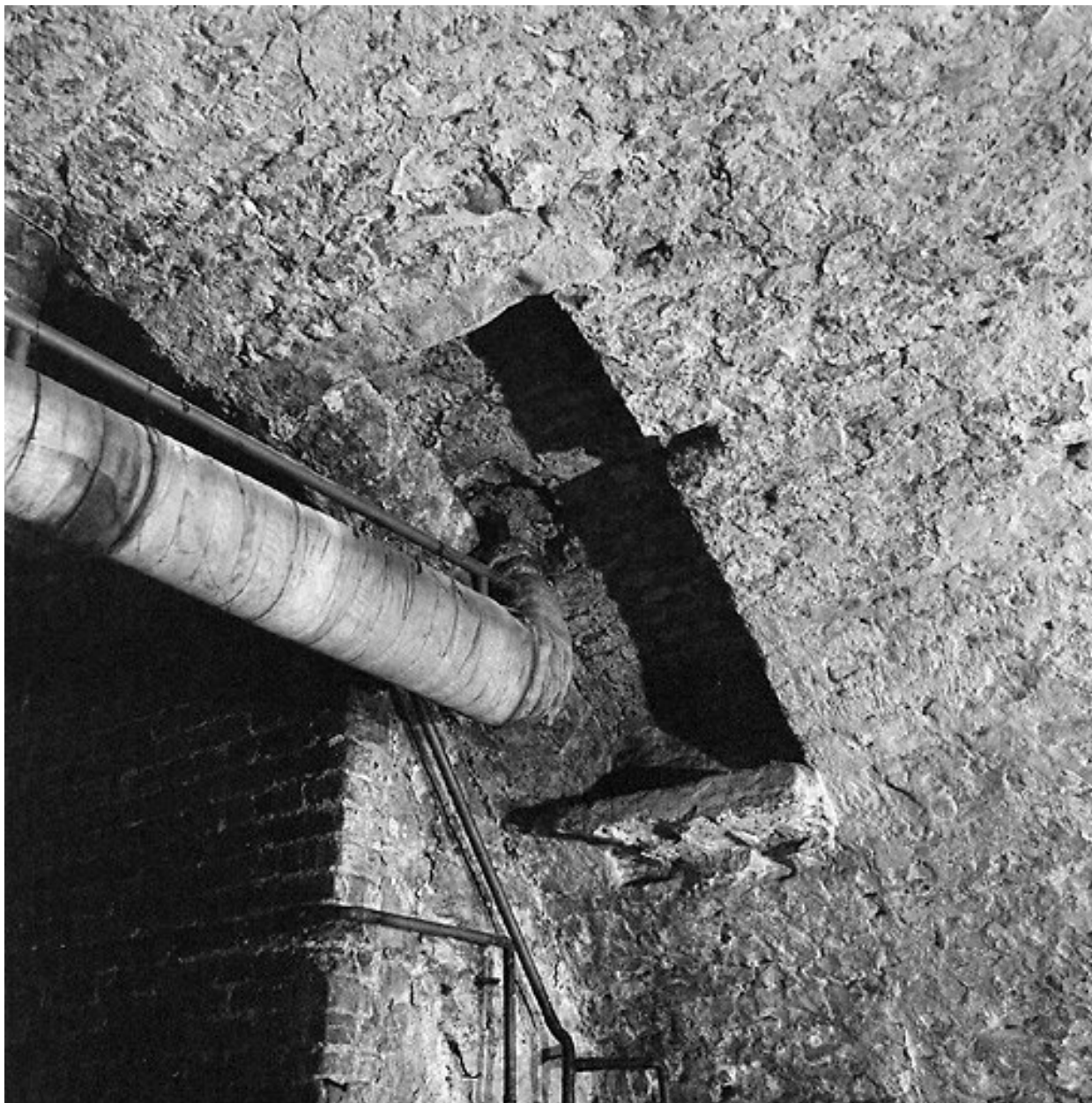
Sous-sol, cave principale : trou d'homme donnant accès, par une échelle, au rez-de-chaussée de la maison médiévale.
