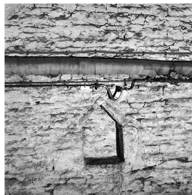
Sous-sol, cave principale : mur arrière, niche couverte en bâtière. Phot. Pierre Thibaut IVR31_20055901131X
