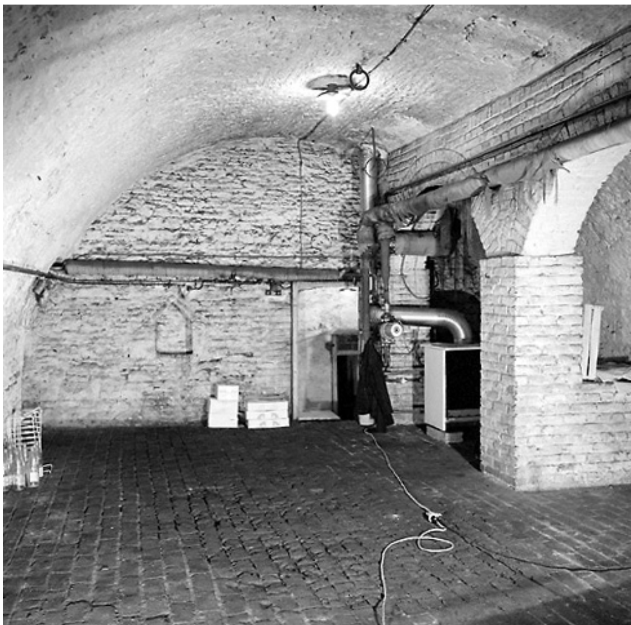
Sous-sol, cave principale : vue générale vers l'arrière.
