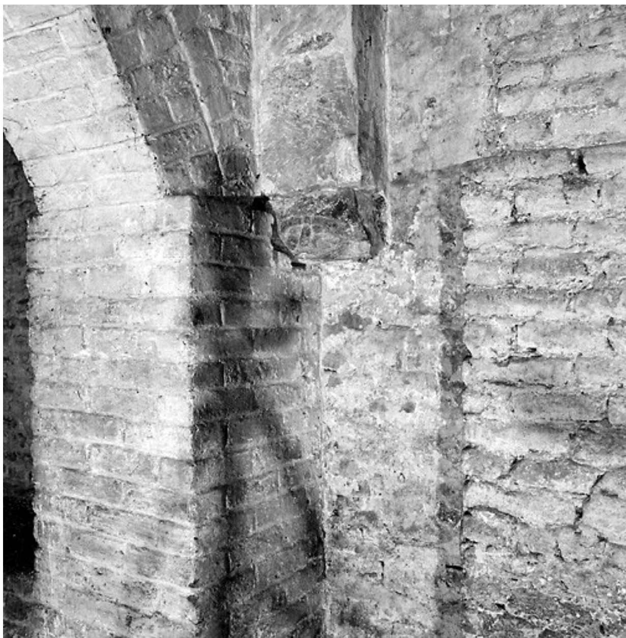
Sous-sol, cave principale : à droite, mur de façade de la cave, corbeau sculpté et emplacement muré de l'escalier d'origine ouvrant sur la rue.
