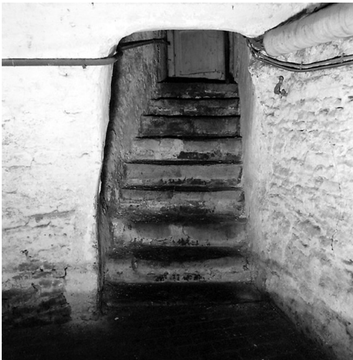
Sous-sol, cave principale : escalier d'accès actuel.
