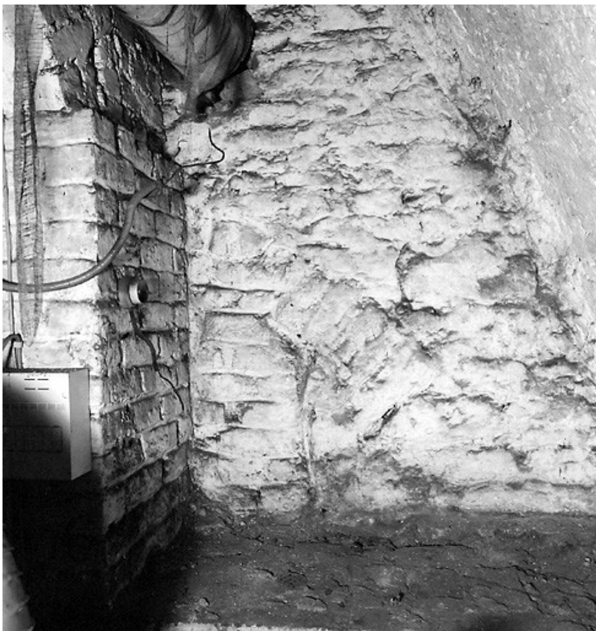
Sous-sol, cave principale : mur arrière, amorce de l'arc vers l'ancienne ouverture vers la cave arrière.
