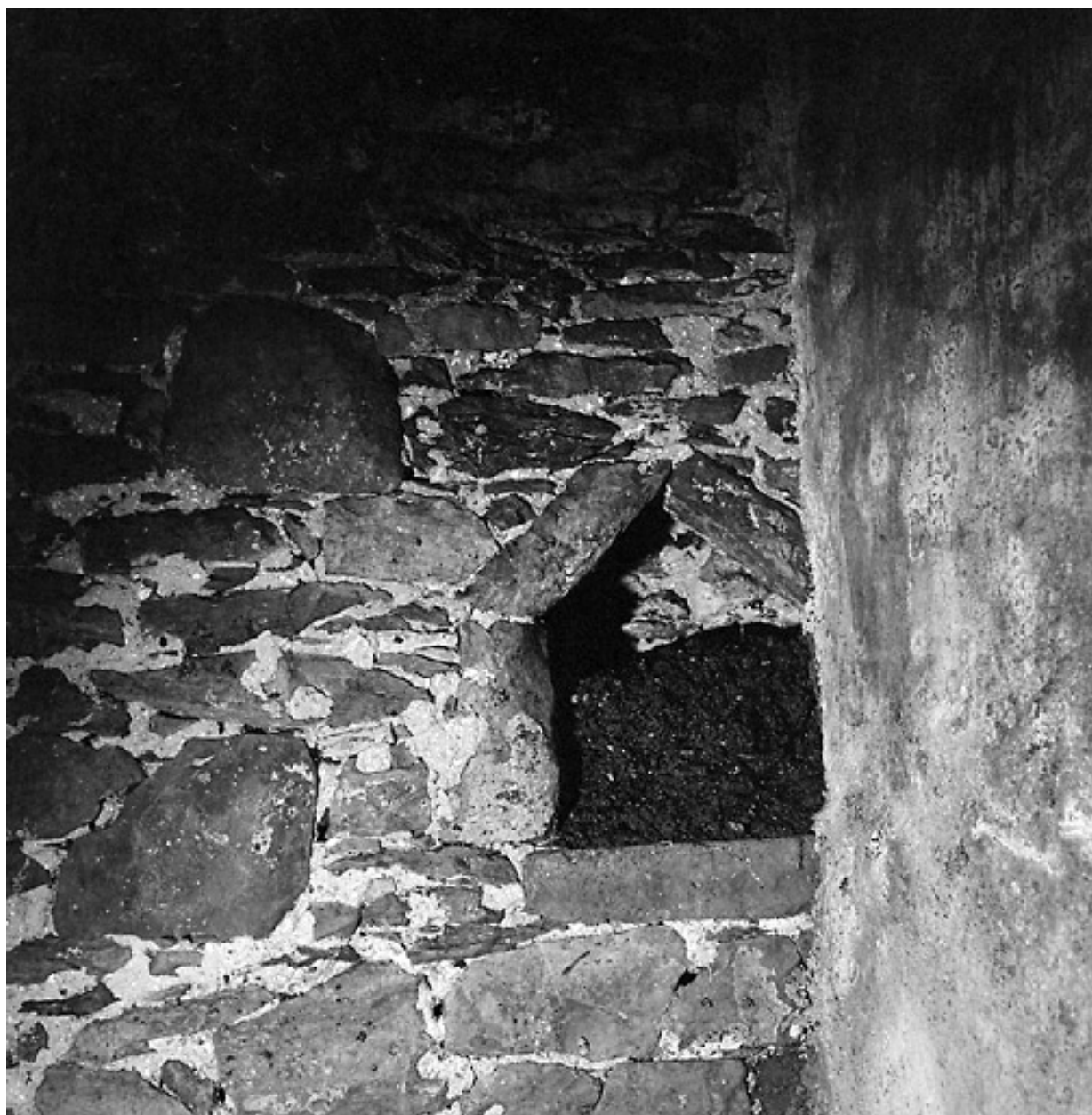
Sous-sol, cave sous la cour : mur arrière, niche couverte en bâtière.
