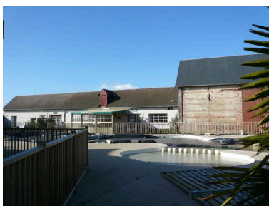
Vue des étables au nord. Phot. Inès Guérin IVR22_20078005421NUCA
