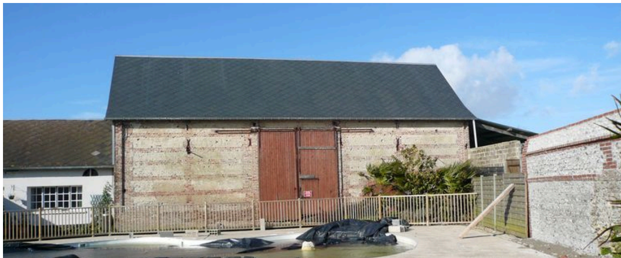
Vue de la grange au nord de la cour.
