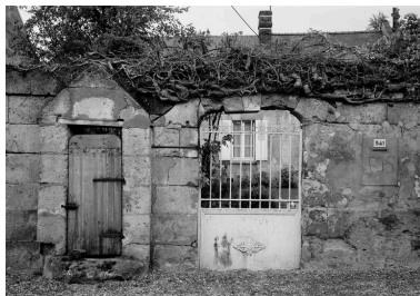
Portail et puits. Phot. Jean-Michel Perrin IVR22_19856000762X
