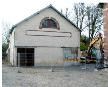
La halle aux vins en cours de démolition, avril 2003 (AC Nogent-sur-Oise). Phot. Clarisse Lorieux IVR22_20096005012NUCA
