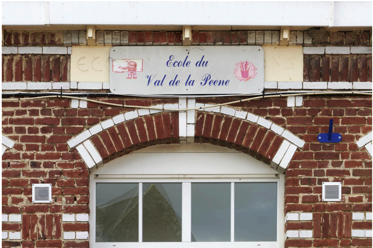
Détail de la façade sur rue.
