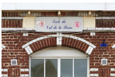
Détail de la façade sur rue. Phot. Delphine Volto Jourdan IVR32_20245903279NUCA
