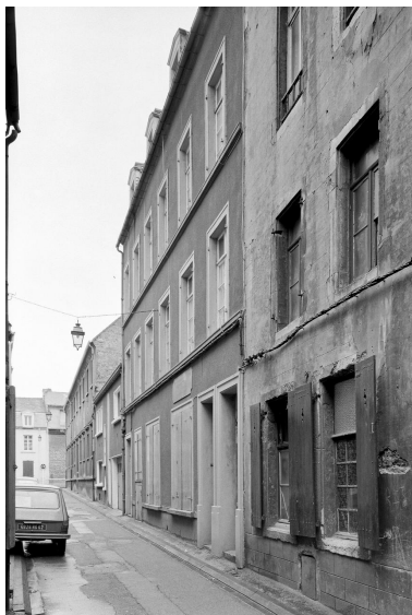
Vue générale sur voie. Phot. Jean-Michel Périn IVR31_19806203974X
