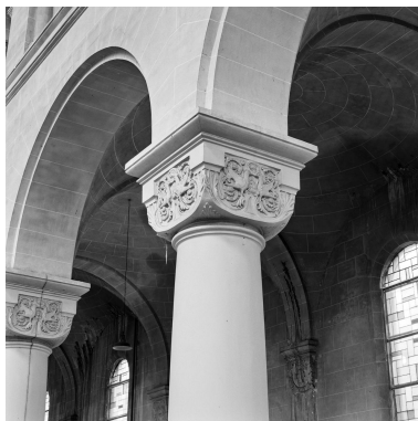
Vue de la nef, détail : colonne et chapiteau. Phot. Philippe Dapvril IVR31_20025900788X
