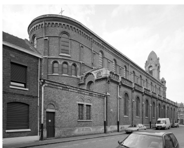
Vue générale du sud-est. Phot. Philippe Dapvril IVR31_20025900801V
