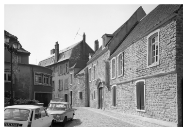
Façade sur voie. Phot. Jean-Michel Périn IVR31_19806202451X
