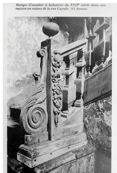
Escalier intérieur, rampe, détail. Extrait du livre : Wimet (P.A.), Boulogne-sur-Mer, cliché Cl. Sarazin. Phot. Jean-Michel Périn IVR31_19816200273XB
