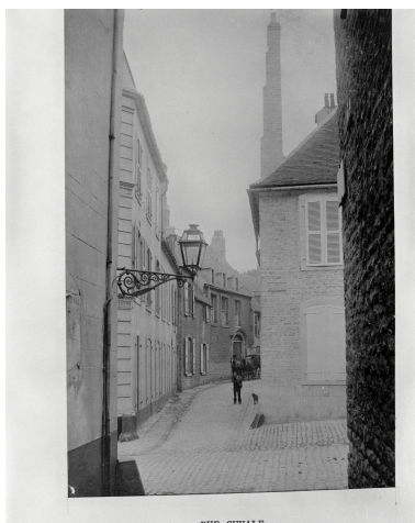
Vue générale. A.C. Boulogne-sur-Mer, division cartes postales, série rues de Boulogne. Phot. Jean-Michel Périn IVR31_19806201885XB
