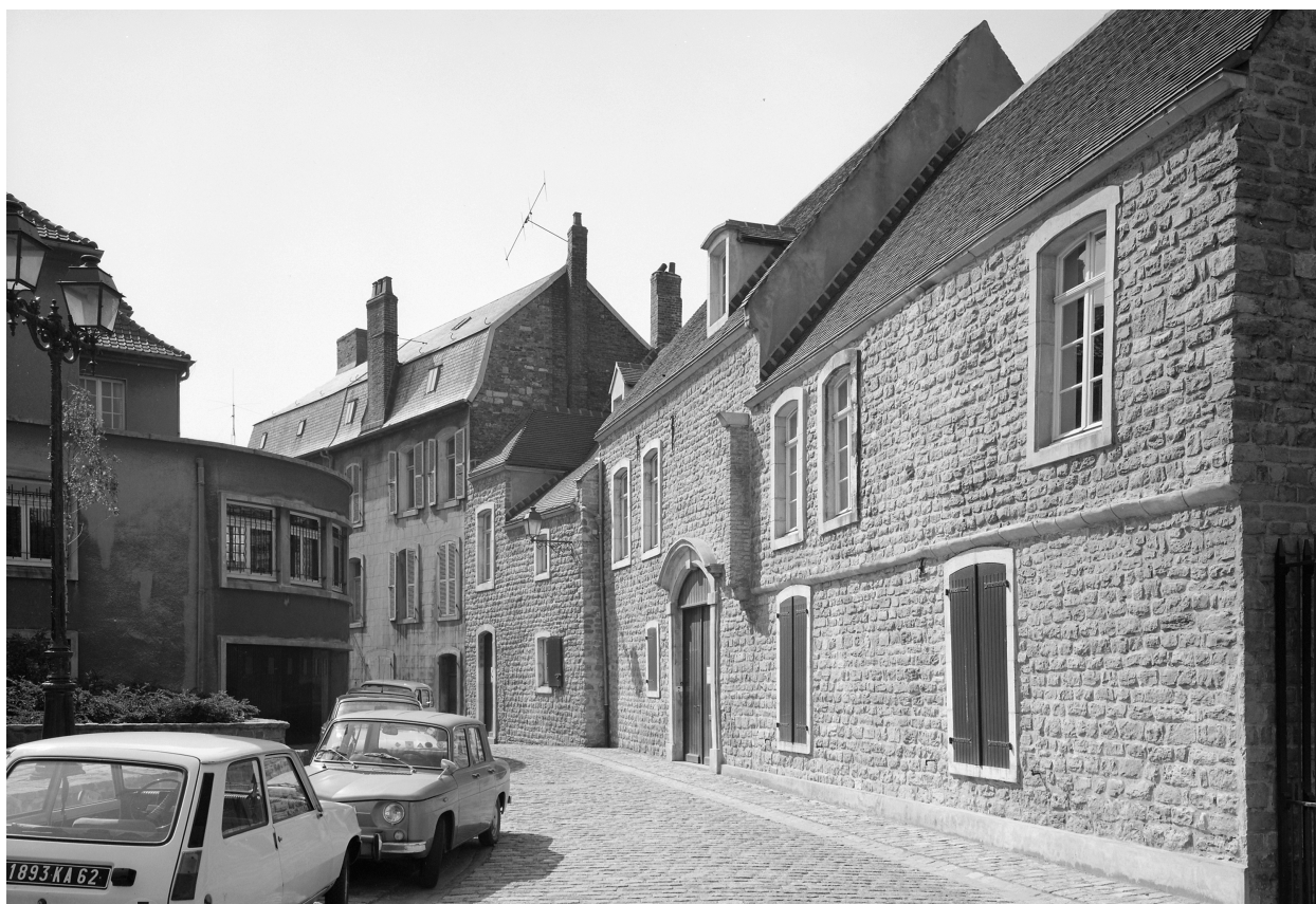
Façade sur voie.
