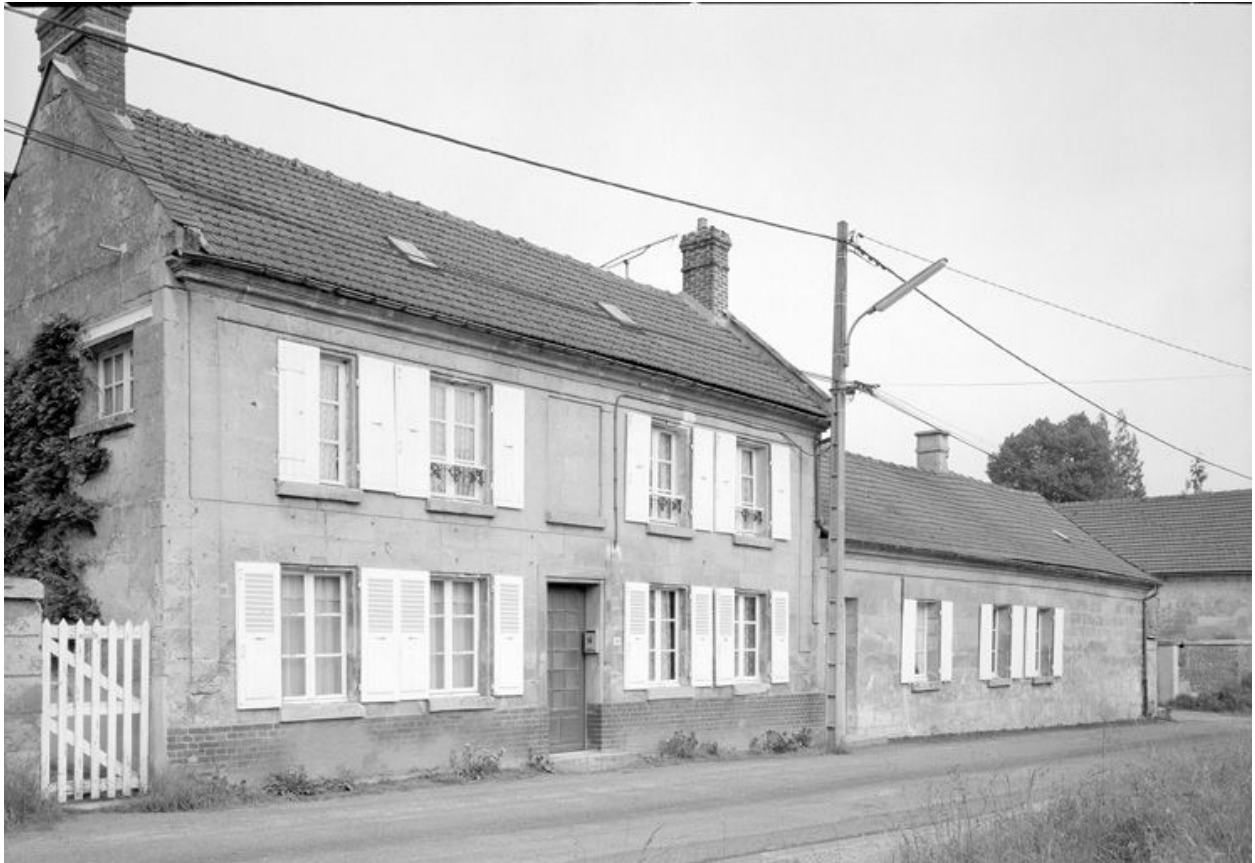
Logis. Elévation antérieure.
