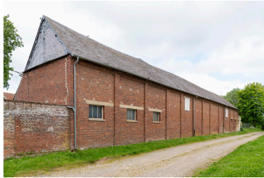
Bâtiments agricoles reconstruits à l'emplacement de la ferme de l'ancien château avec murs des anciens bâtiments à l'extrémité. Phot. Marc Kérignard IVR32_20236000754NUCA
