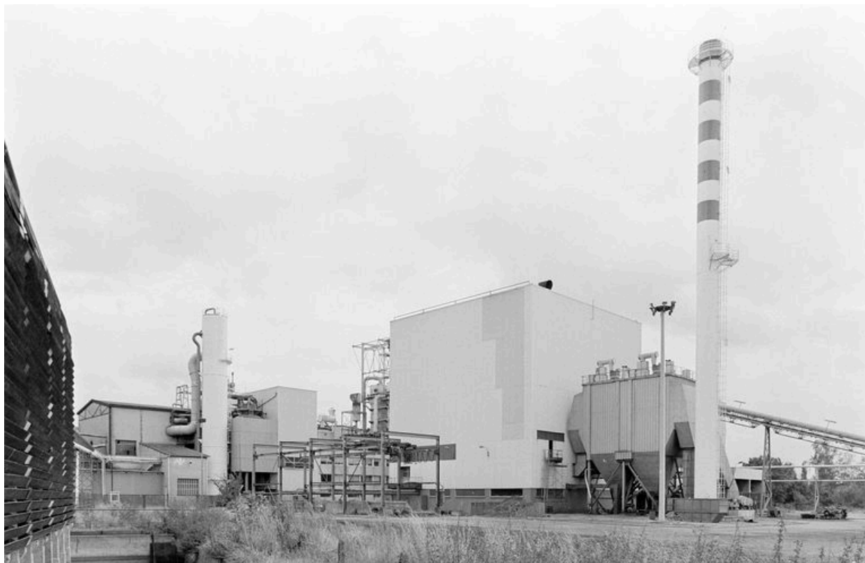
Vue générale de l'usine, flanc ouest.
