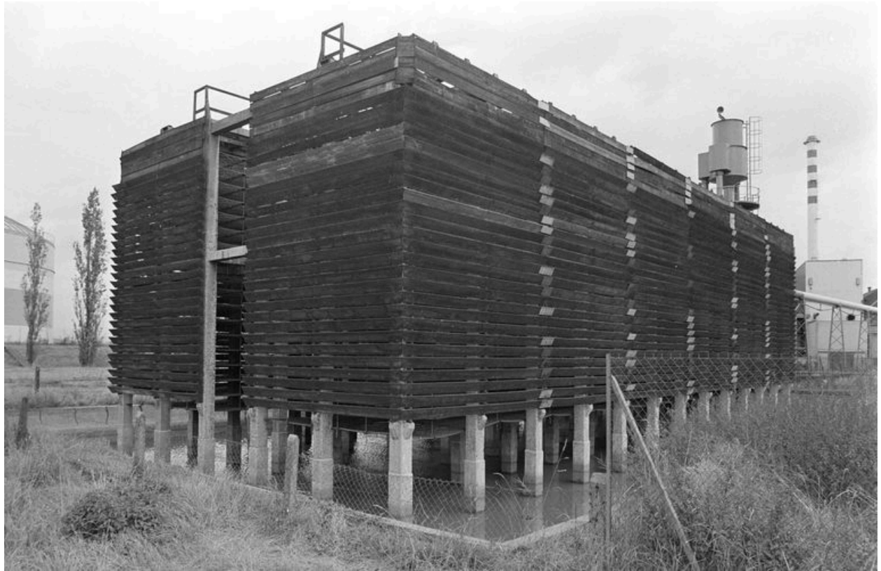
Réfrigérant : vue générale.
