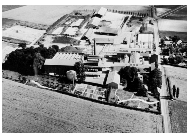
Vue aérienne, en 1967 (AP). Phot. Benoît Dufournier IVR22_19936002290ZB
