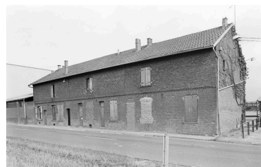
Logement d'ouvriers. Phot. Benoît Dufournier IVR22_19936002299Z
