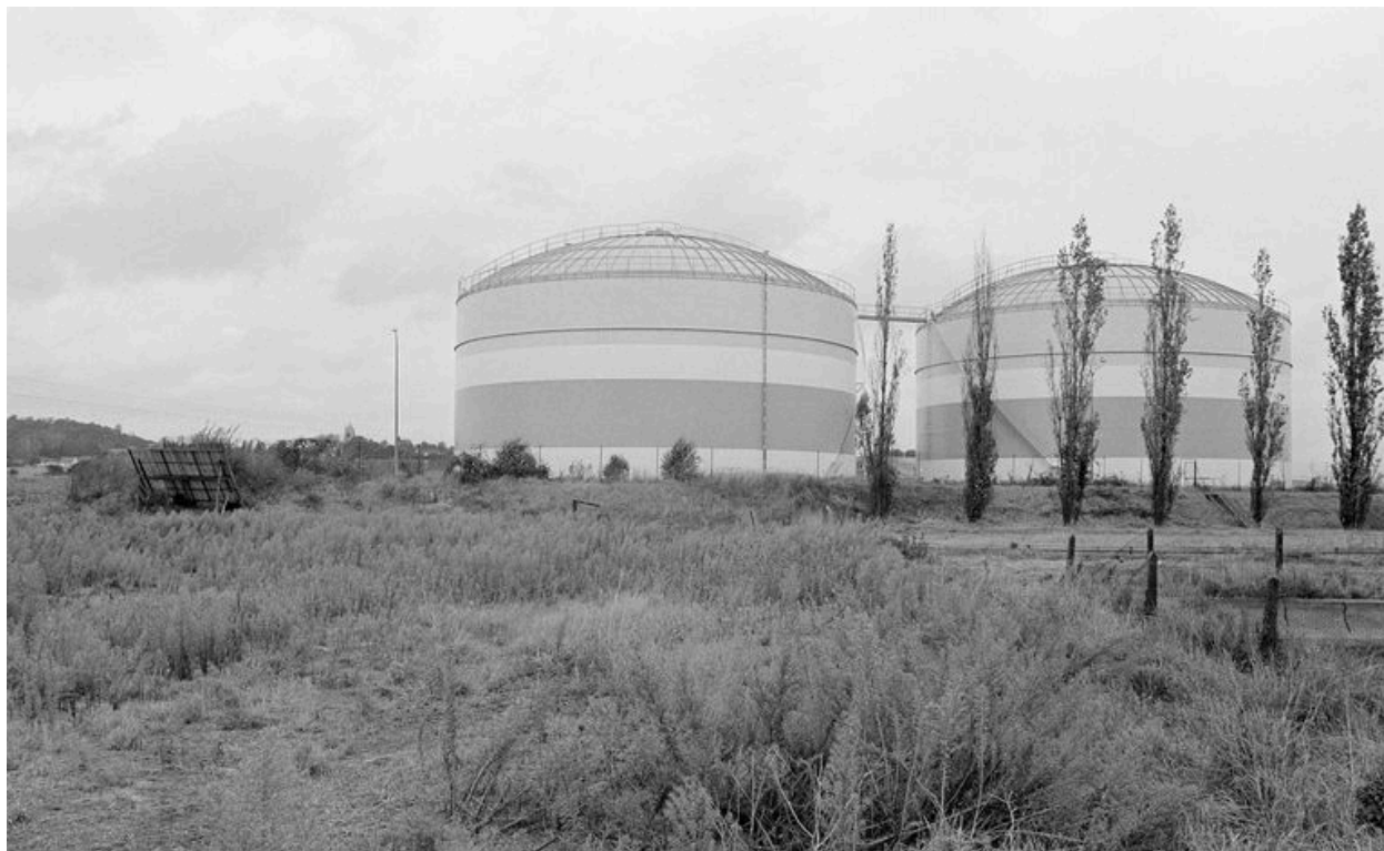
Les silos, vue générale.
