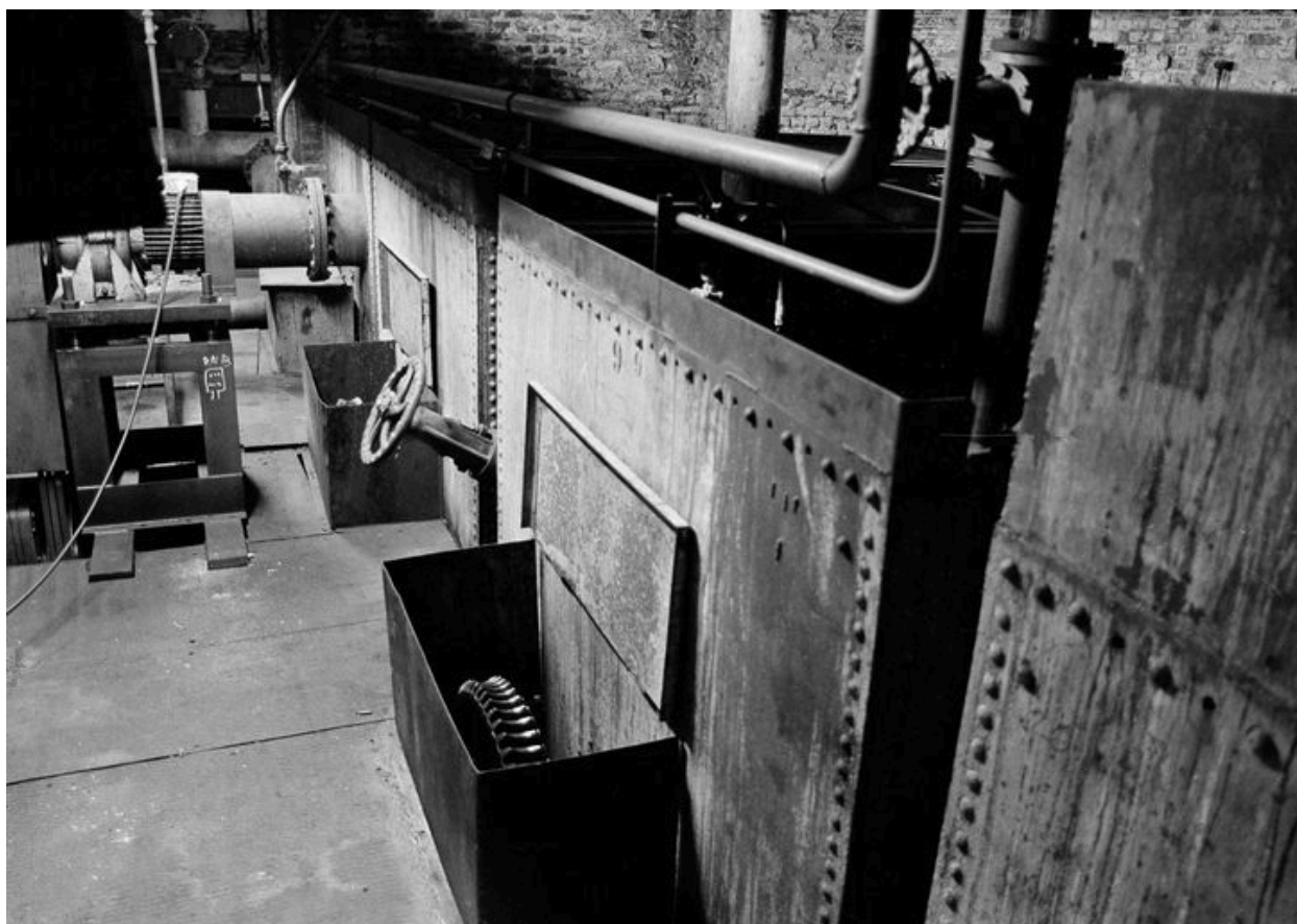
Atelier de fabrication (cristallisation) : vue intérieure.
