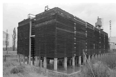
Réfrigérant : vue générale. Phot. Benoît Dufournier IVR22_19936002294Z
