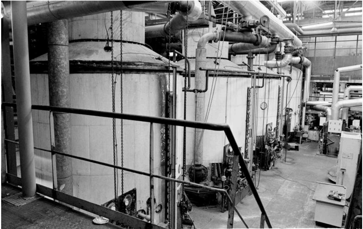
Atelier de fabrication (cristallisation) : vue intérieure.
